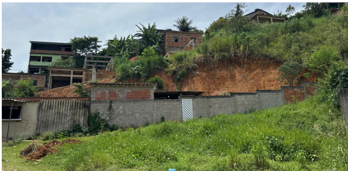
Figura 1. Talude de corte, com rua asfaltada a montante e casas a jusante
