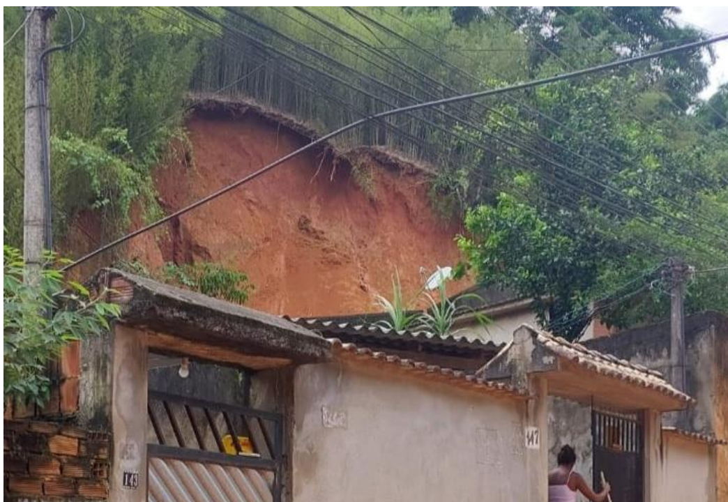
Figura 1: Deslizamento planar que impactou as residências 147 e 155
