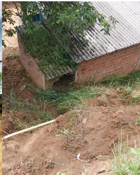
Figuras 2: Deslizamento planar a montante da via Figura 3: Casa atingida a jusante da via
