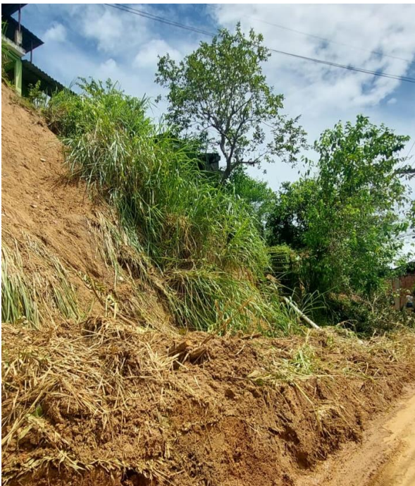
Figuras 2: Deslizamento planar a montante da via Figura 3: Casa atingida a jusante da via
