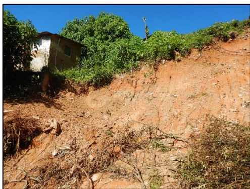
Figura 10. Construção próxima à crista da cicatriz.
