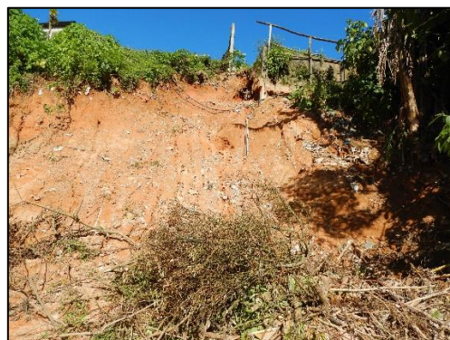
Figura 11. Deslizamento planar.
