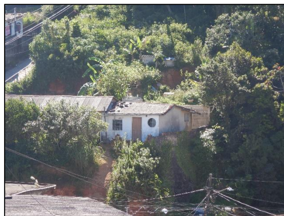
Figura 7. Construção no topo de deslizamento.
