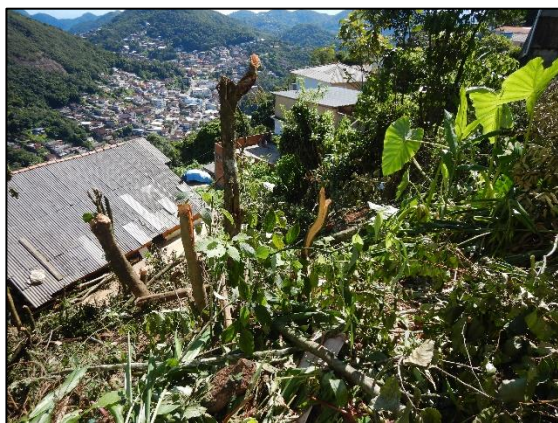
Figura 6. Talude de corte a montante de residência.
