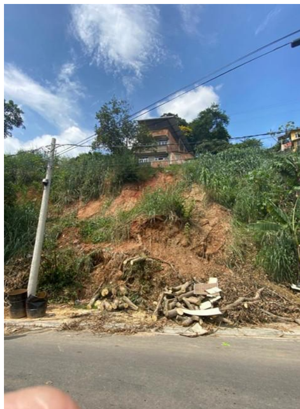
Figura 6: Imagem frontal da cicatriz 3. Não havia residências próximas para englobar no polígono de risco referente a essa cicatriz.
