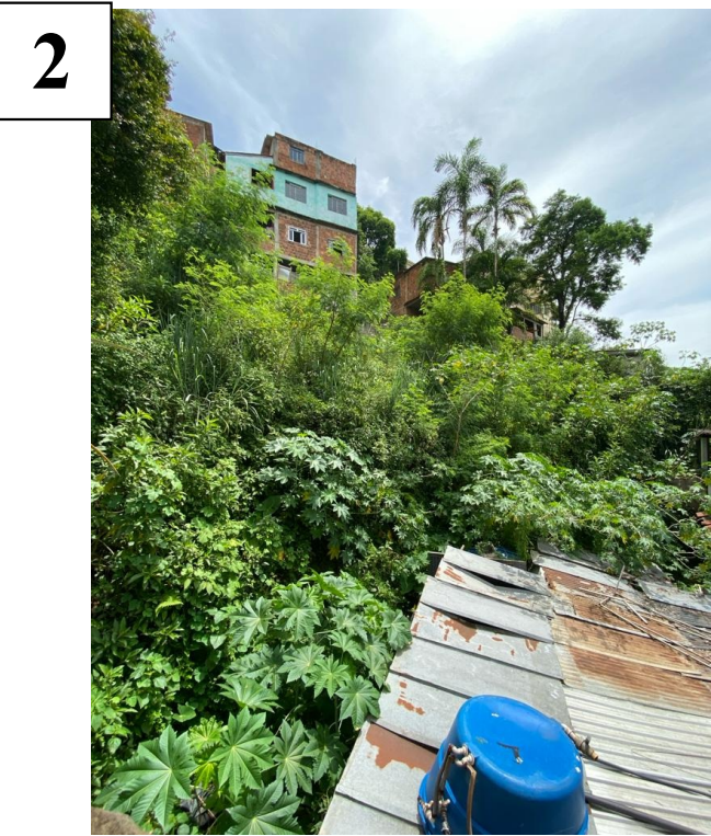
Ocupação dentro da drenagem natural.
