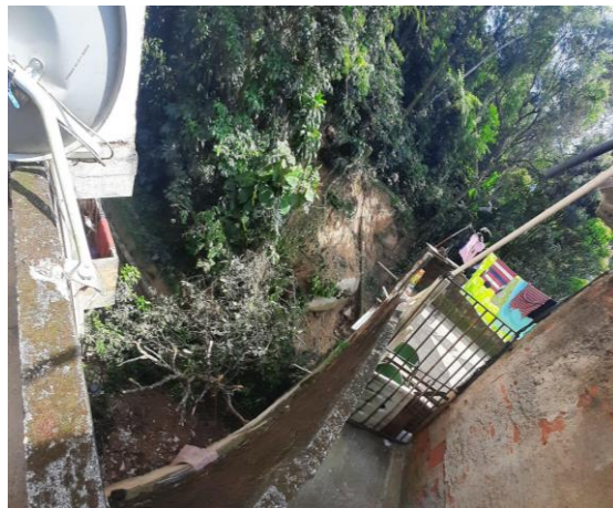
Figura 2: Residências localizadas junto a drenagem encaixada, nesta observam-se os rastros da enxurrada, com presença de blocos de rocha e com exposição de solo devido ao processo erosivo.
