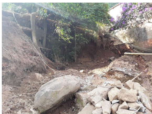
Figura 3: Vista da casa na base e topo do talude.
