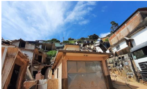
Figura 5: Deslizamento e imóvel destruído.
