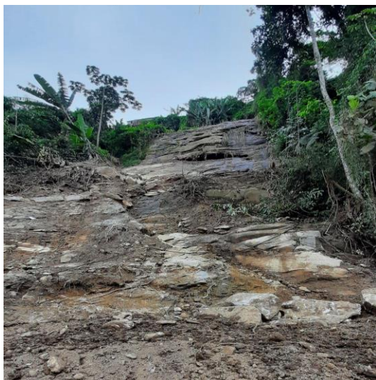
Figura 3: Cicatriz de deslizamento
