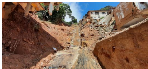
Figura 1: Visão geral das casas atingidas pelo fluxo de detritos.
