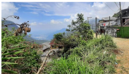
Figura 1: Casas próximas na margem do talude.
