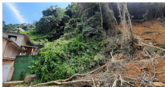
Figura 2: Casa atingida pelo fluxo de detritos
