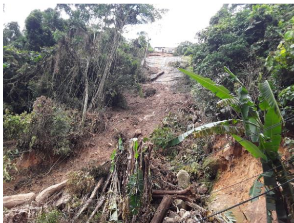
Figura 2: cicatriz de deslizamento.
