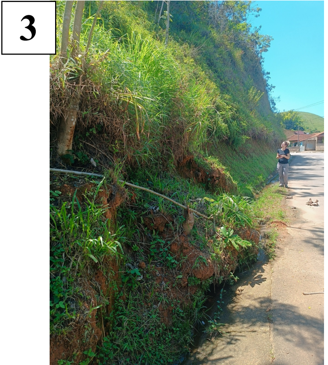
Material da encosta proveniente do deslizamento pretérito que avançou até a lateral da via, obstruindo parcialmente a canaleta, porém não atingiu a via ou casas. Observar que a vegetação já está recomposta, mostrando que se trata de um movimento antigo.
