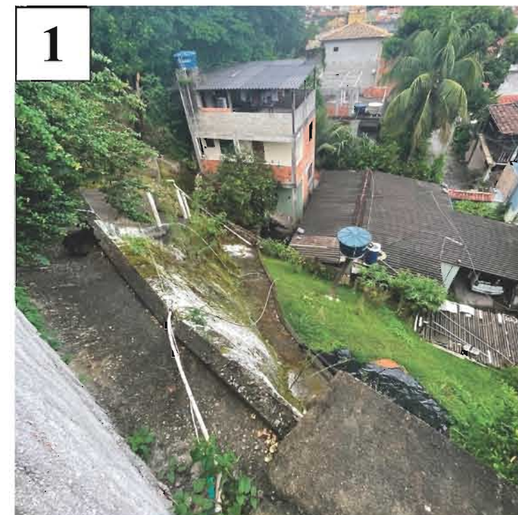
Vista de cima do talude a partir do imóvel n.º 535 casa 2.
