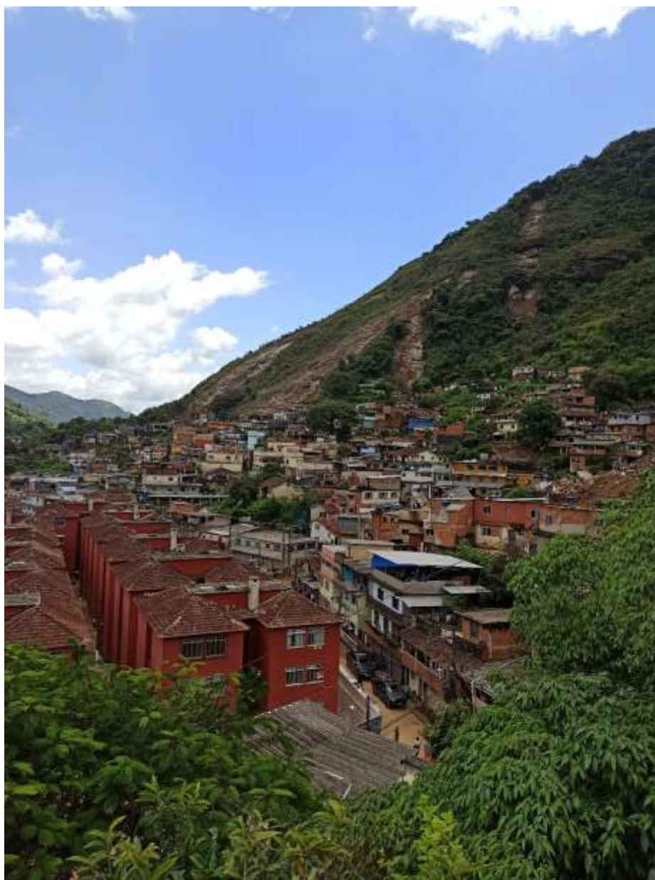
Figura 5. Imagem mostrando a comunidade localizada atrás do BNH Alto da Serra, e ao fundo, as cicatrizes dos deslizamentos ocorridos no dia 15/02/22.
