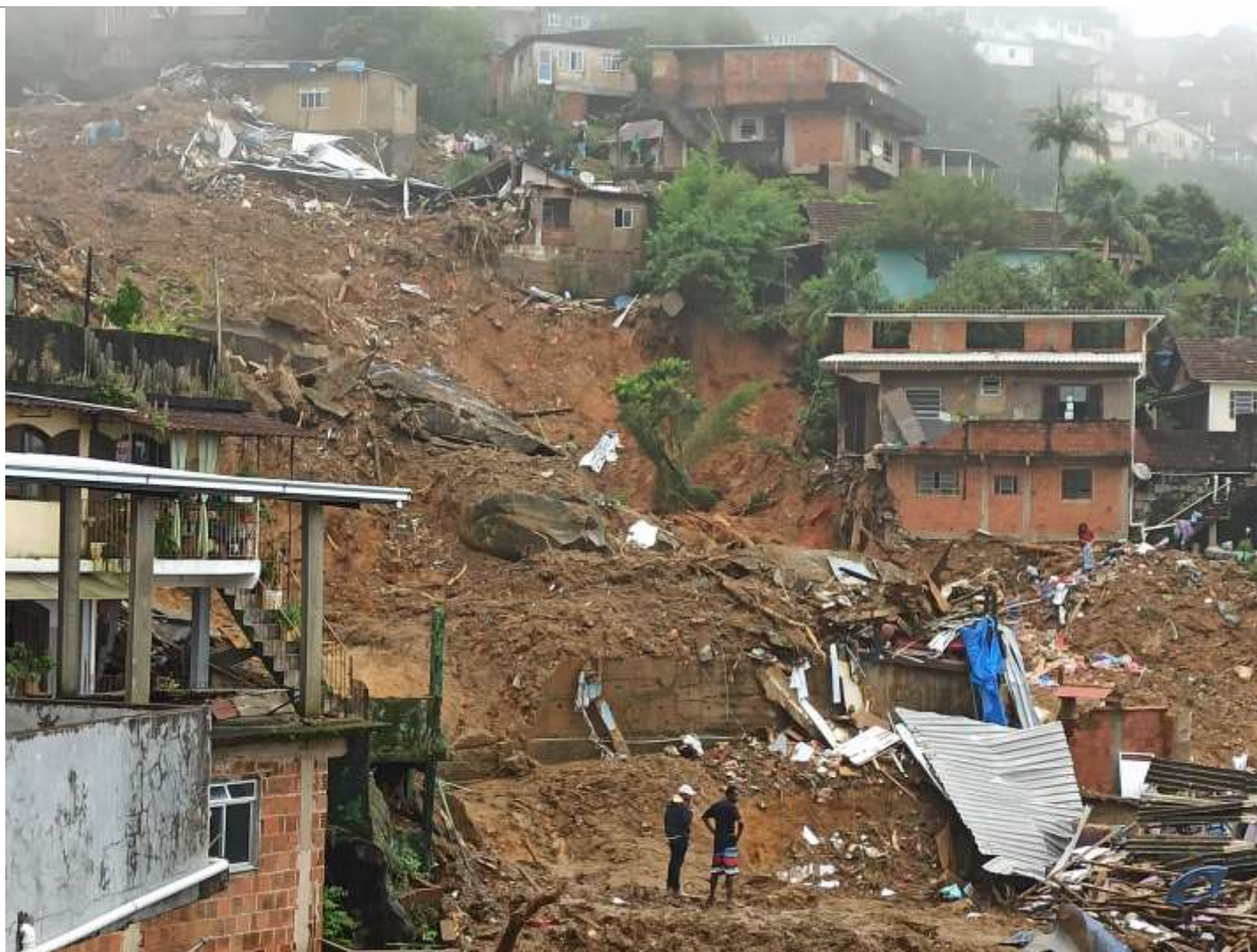
Figura 2. Imagem mostrando a localização da área de risco 1, e a área afetada pelo deslizamento / corrida de massa no dia 15/02/22.
