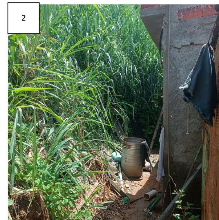
Lote 35, quadra 5. Distância de 1,5m das moradias para o talude de corte.
