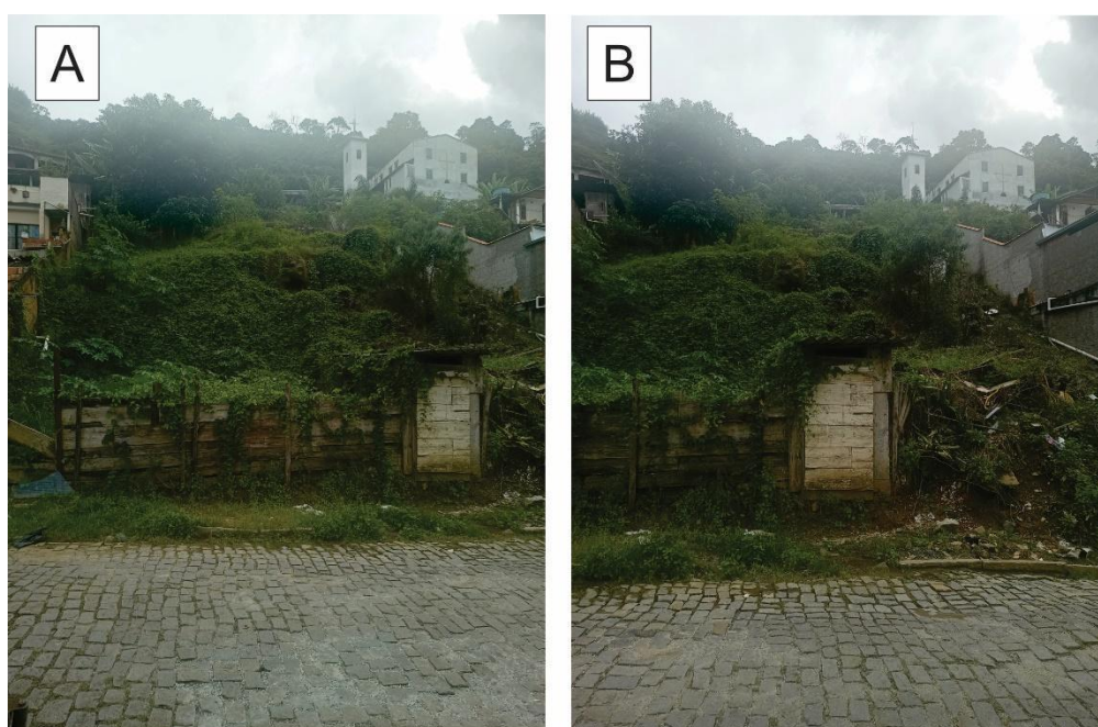
Figura 6: Antiga residência destruída nos escorregamentos de 2007.
