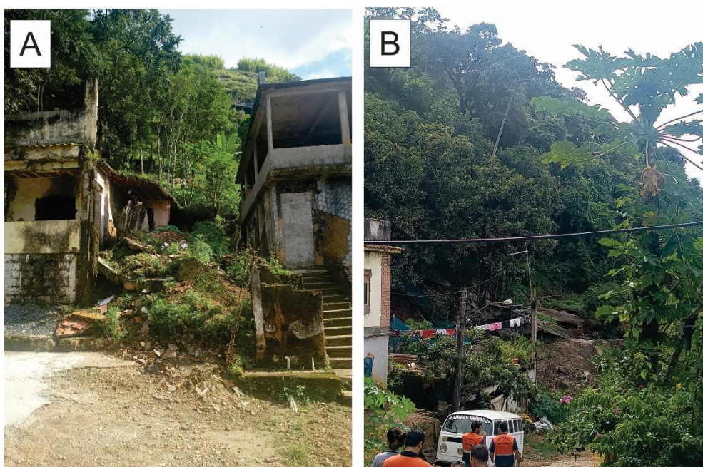
Figura 4: A – Casas locais totalmente destruídas pelos acidentes de 2007, novamente ocupadas. B – depósito de tálus ao fundo decorrente do acidente de 2007.
