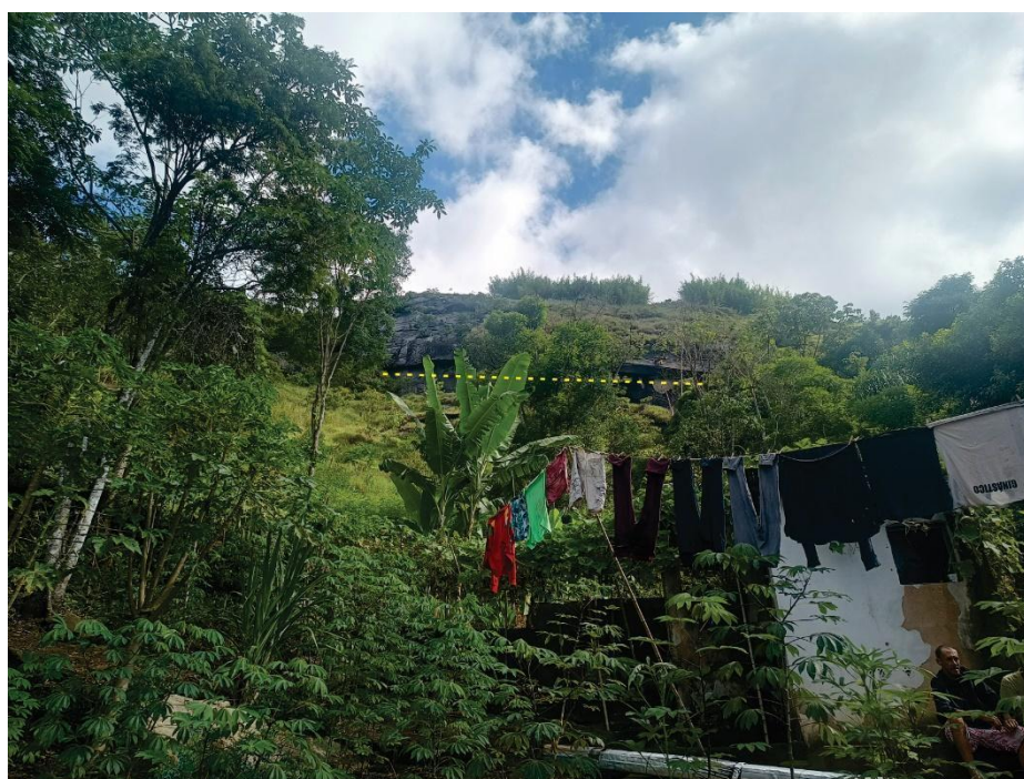
Figura 5: Imagem do maciço de onde houve o desprendimento dos blocos. A linha amarela tracejada indica o local da fratura de alívio.
