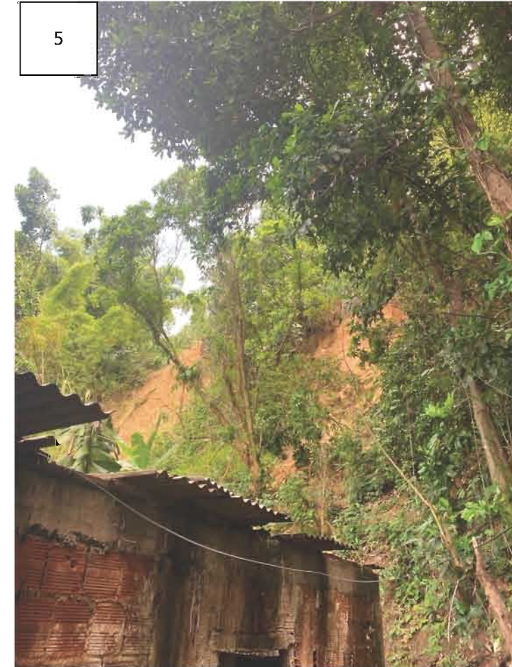
Deslizamento planar em talude de corte nas proximidades das residências.
