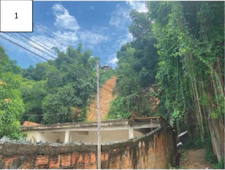
Cicatriz de deslizamento nas proximidades da residência de número 396.
