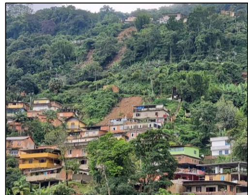
Figura 25. Visão geral de encosta do bairro Pontilhão.
