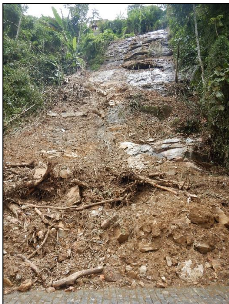
Figura 18. Encosta com cicatriz de deslizamento planar.
