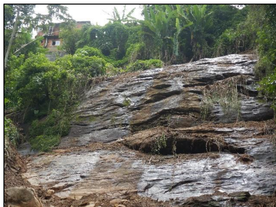
Figura 17. Visão de construção no topo de cicatriz de deslizamento.
