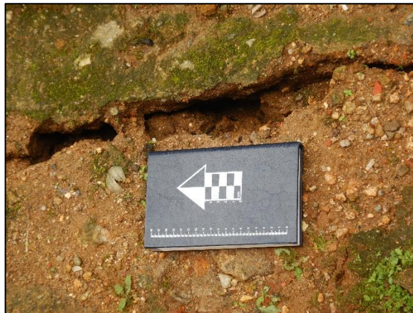
Figura 9. Trinca no terreno.
