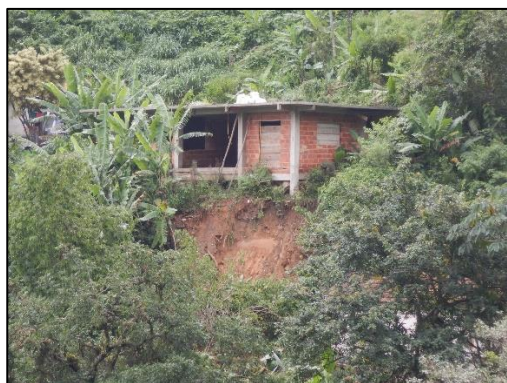
Figura 26. Construção em risco muito alto.
