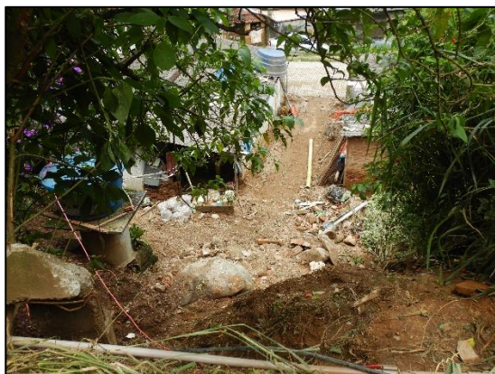
Figura 22. Moradia atingida pelo fluxo de detritos.
