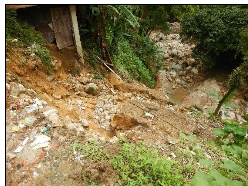
Figura 27. Fundação de construção com risco muito alto.
