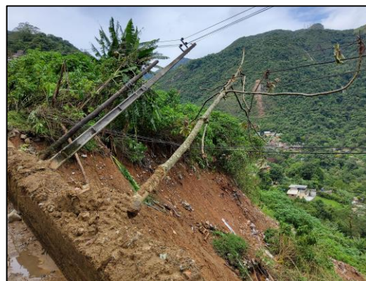
Figura 13. Postes inclinados.
