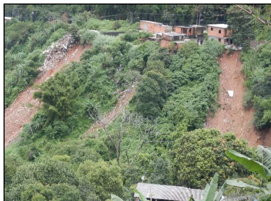
Figura 11. Moradias com risco muito alto.
