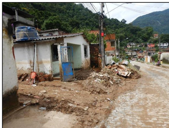
Figura 23. Moradia atingida pelo fluxo de detritos.
