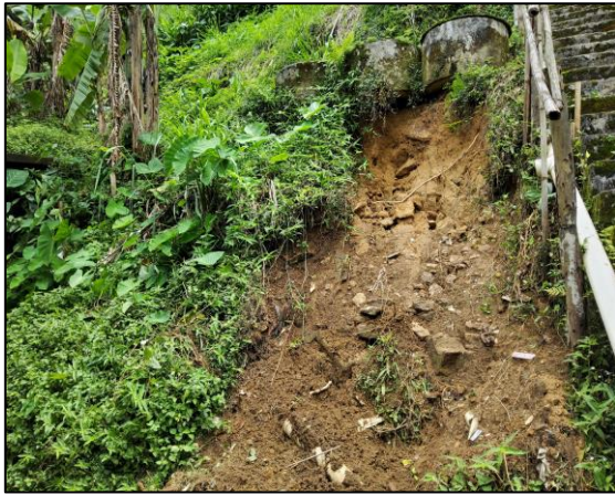
Figura 4. Exemplo de deslizamentos planares menores.
