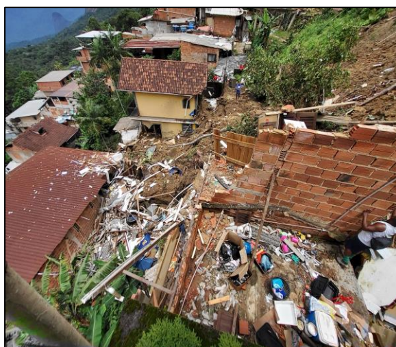
Figura 3. Detalhe das construções destruídas.
