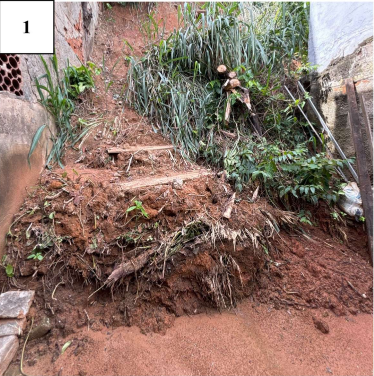
Vista frontal do talude na residência 726
