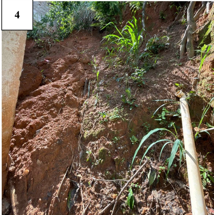
Vista do talude nos fundos da residência 726 Casa 1
