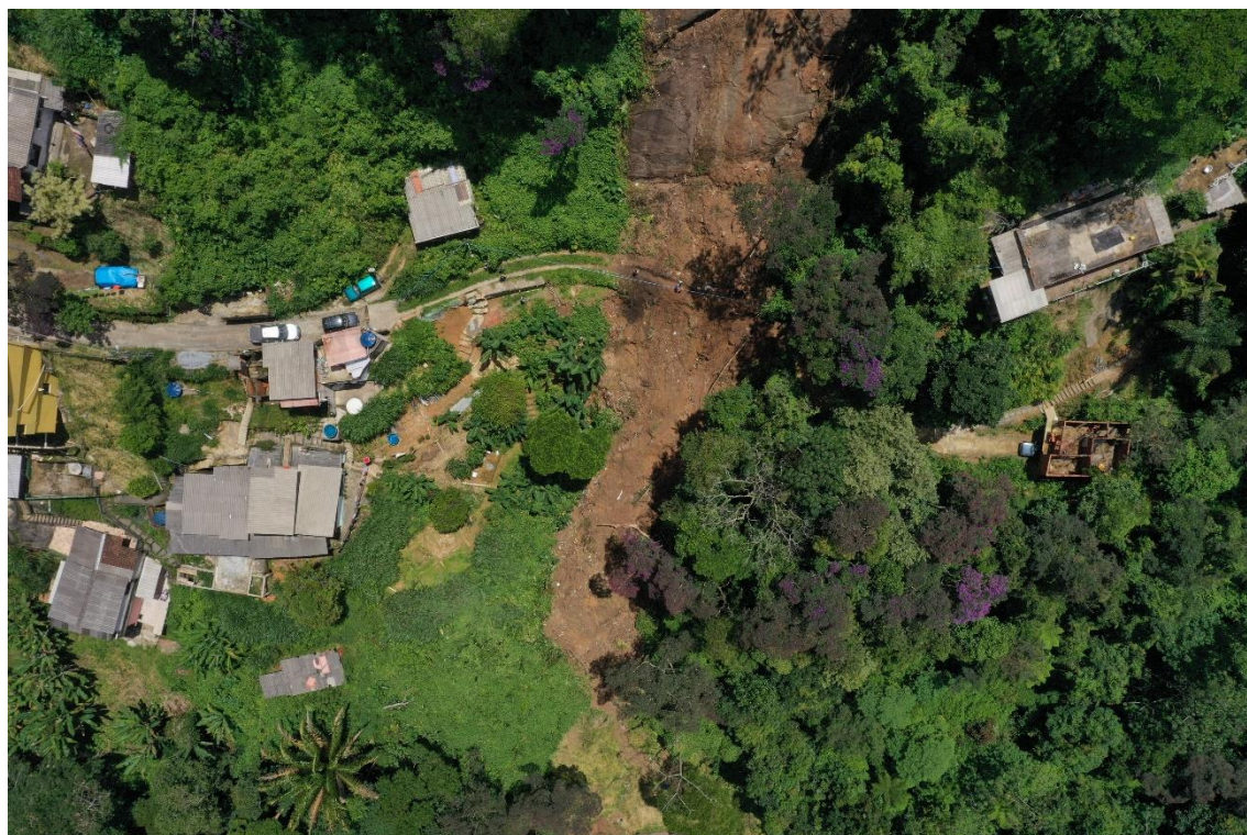
Figura 2 – Vista do Deslizamento, obtida por drone (Águas do Rio).
