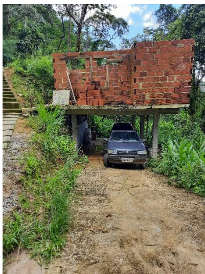
Figura 6 – Vista da construção irregular, da rampa de acesso a residência e do deslocamento na rampa.
