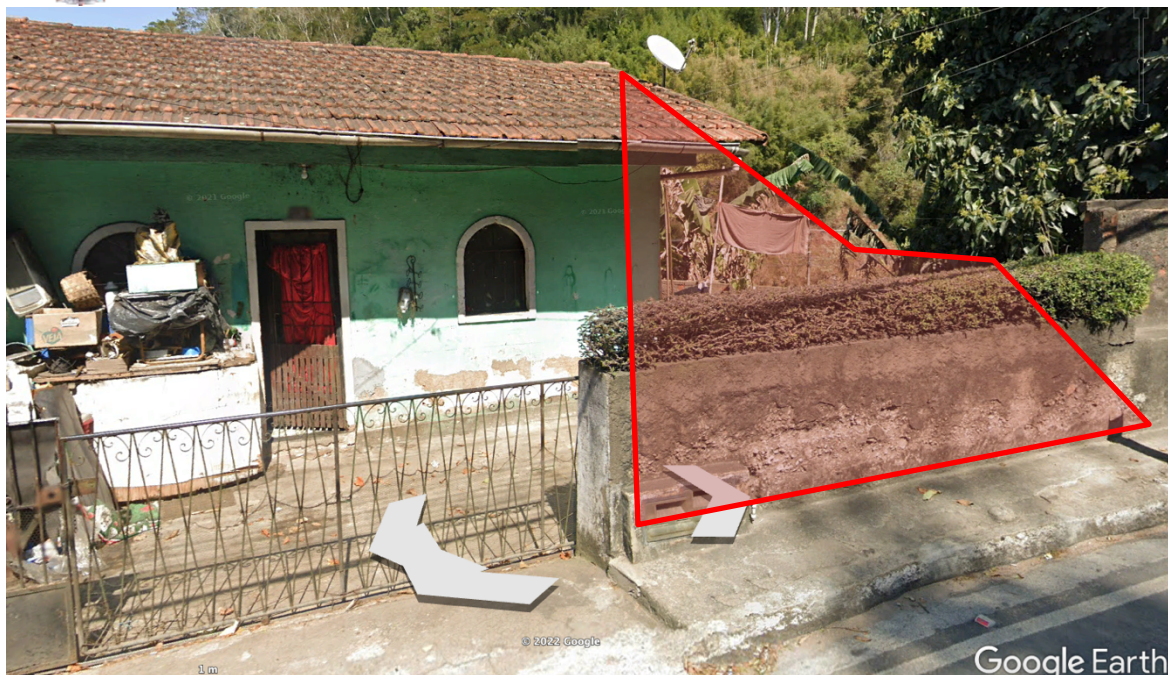
Figura 2 - Vista frontal da área atingida
