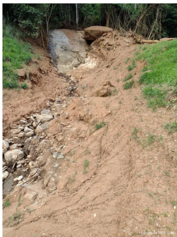
Figuras 3 e 4: Vista do trecho escorregado, com o bloco individualizado; Detalhe da laje de rocha exposta e do matacão deslocado.
