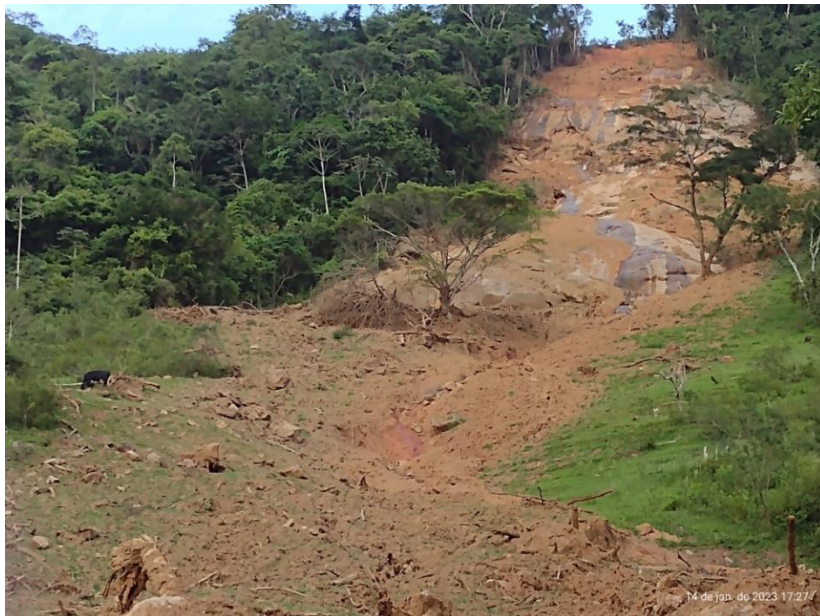
Figura 6: Escorregamento do tipo planar, na mesma propriedade, mas em outra vertente onde movimentou-se uma grande massa de solo e de detritos formados por vegetais de diversos portes, com exposição de uma grande área rochosa.
