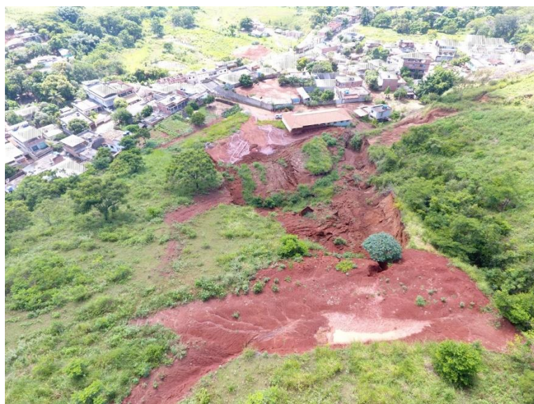
Figura 4: Vista do topo da colina no sentido jusante, direção do escorregamento.
