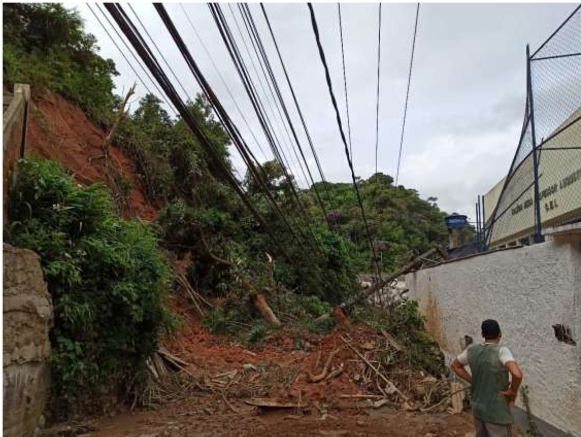
Figura 6. Deslizamento atingindo o CEI e obstruindo totalmente a via.
