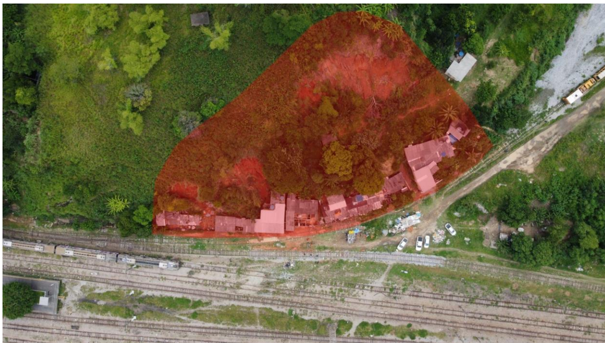
Figura 4: Polígono de Risco Remanescente para a área vistoriada. Fonte da imagem: Defesa Civil de Petrópolis.
