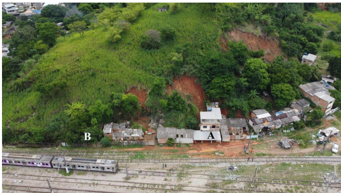
Figura 1: Imagem aérea oblíqua da área vistoriada. A- prédio com três pavimentos atingido pelo deslizamento; B- local da queda de blocos. Fonte da imagem: Defesa Civil de Petrópolis.
