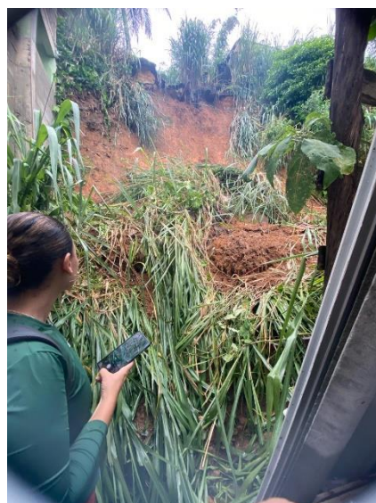
Figura 5:deslizamento planar a montante da via.
