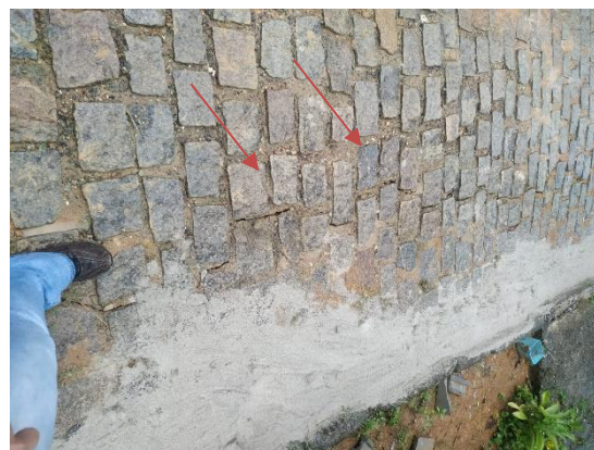
Figuras 2 e 3: Em vermelho, trincas presentes na via.
