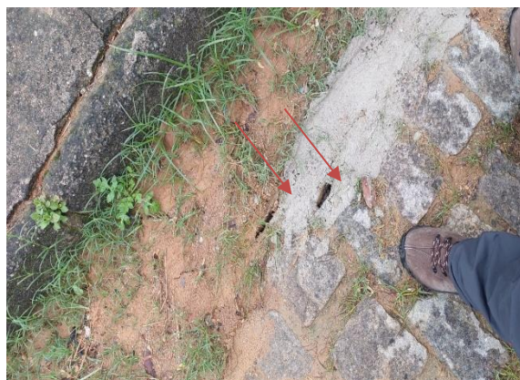
Figuras 2 e 3: Em vermelho, trincas presentes na via.
