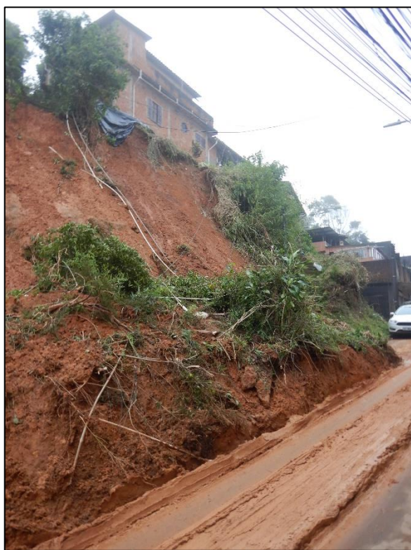
Figura 4. Construção em risco muito alto.
