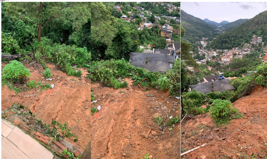
Figura 4 – Residência a jusante da área atingida com risco de soterramento.
