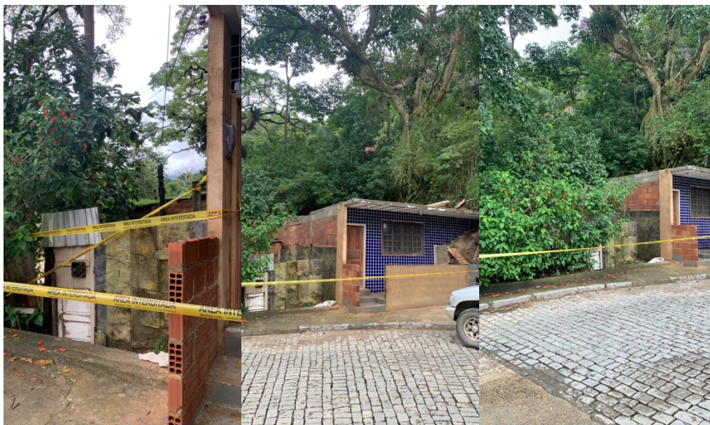
Figura 4 – Isolamento parcial do estabelecimento
