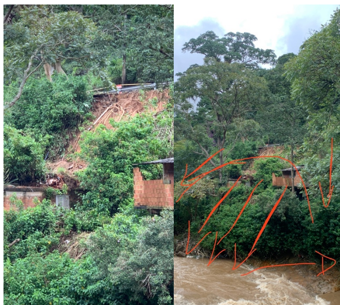
Figura 3 – Escorregamento de talude e árvores, além de ilustração do movimento da massa da encosta
