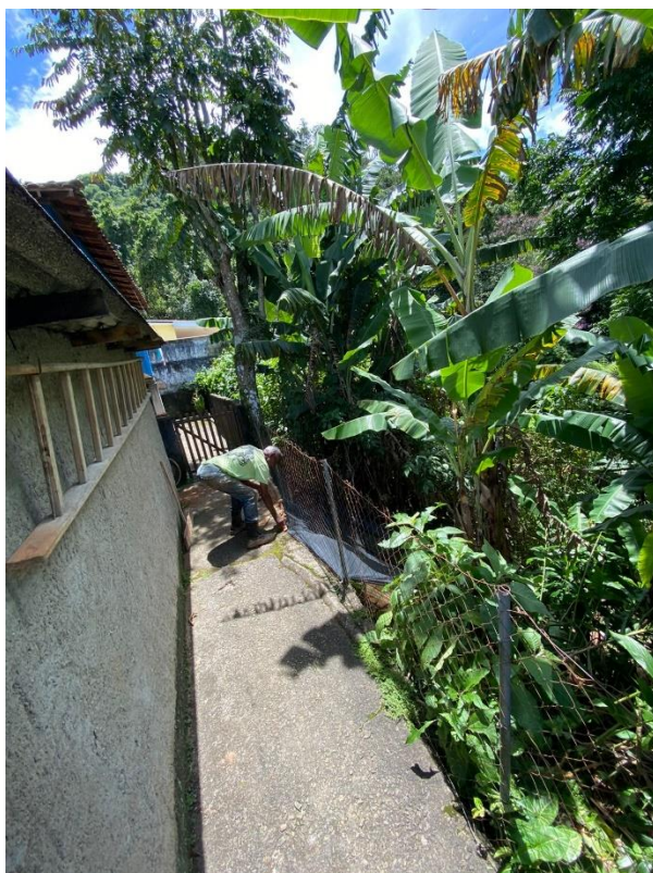
Foto 13: Vista do acesso.
