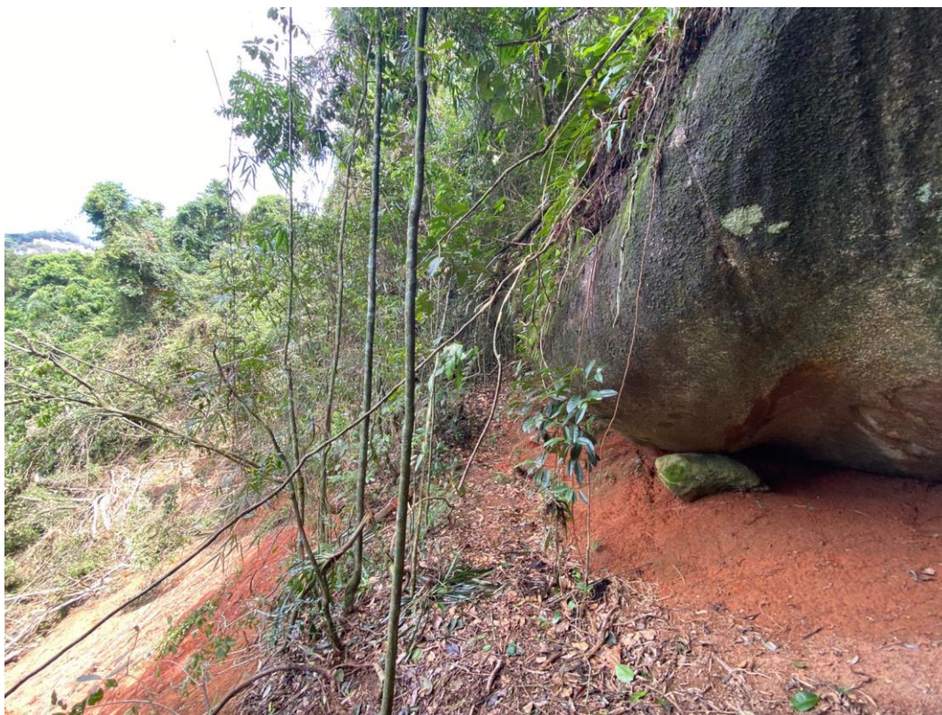
Foto 11: Bloco rochoso próximo à crista do talude.
