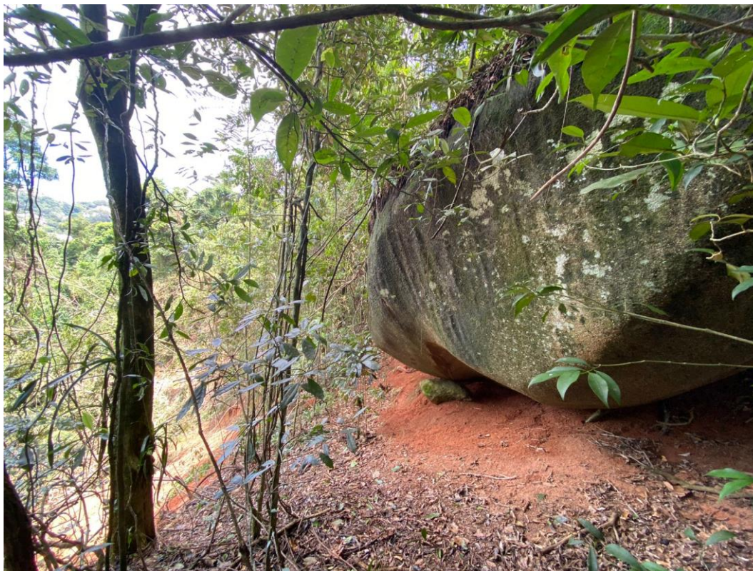
Foto 12: Bloco rochoso próximo à crista do talude.
