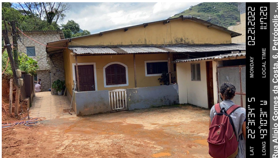
Foto 7: Vista externa da residência
