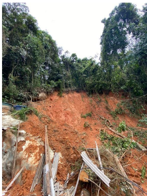
Foto 8: Talude escorregado
