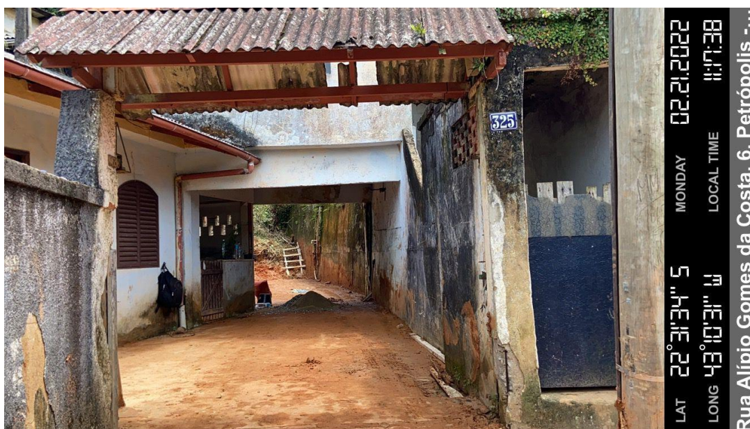
Foto 2: Vista externa da residência
