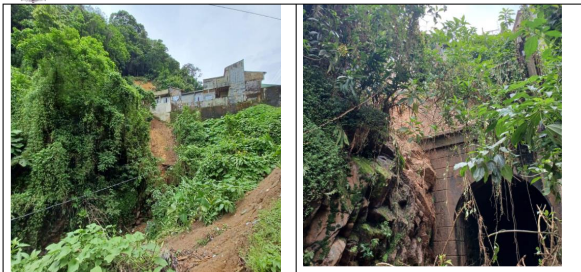
Figura 5. Vistas de montante do túnel.
