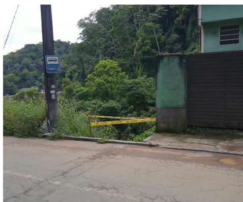
Figura 8. Interdição da escada de acesso ao túnel pela Rua Silva Jardim.
