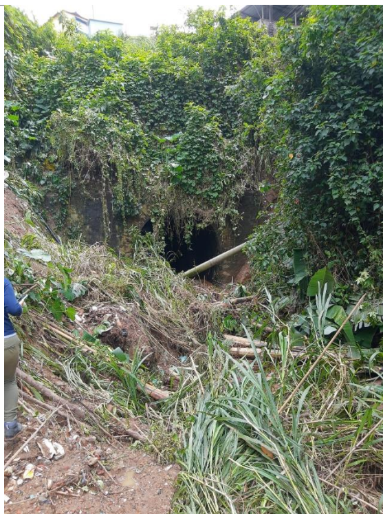
Figura 7. Vista de jusante do túnel.
