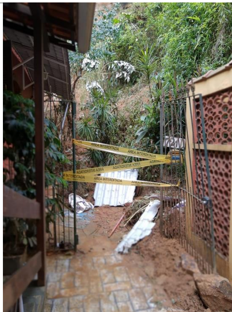
Figura 4. Vista do portão de entrada da residência 721-D com sinalização de interdição.
