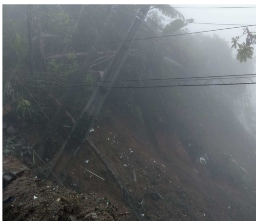
Foto 7 – Danificação da rede elétrica.
