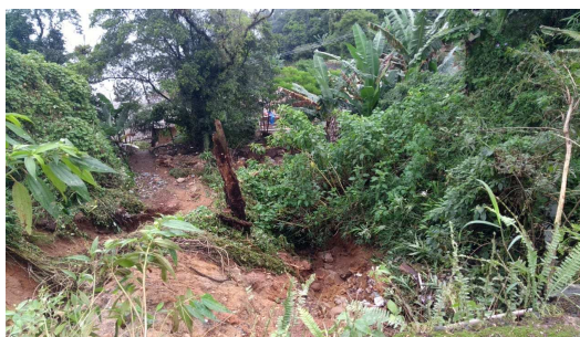
Foto 3 – Deslizamento de material à jusante da via.
