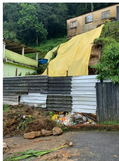
Figuras 01 e 02. Imóvel com deslizamento a jusante comprometendo parte da via.
