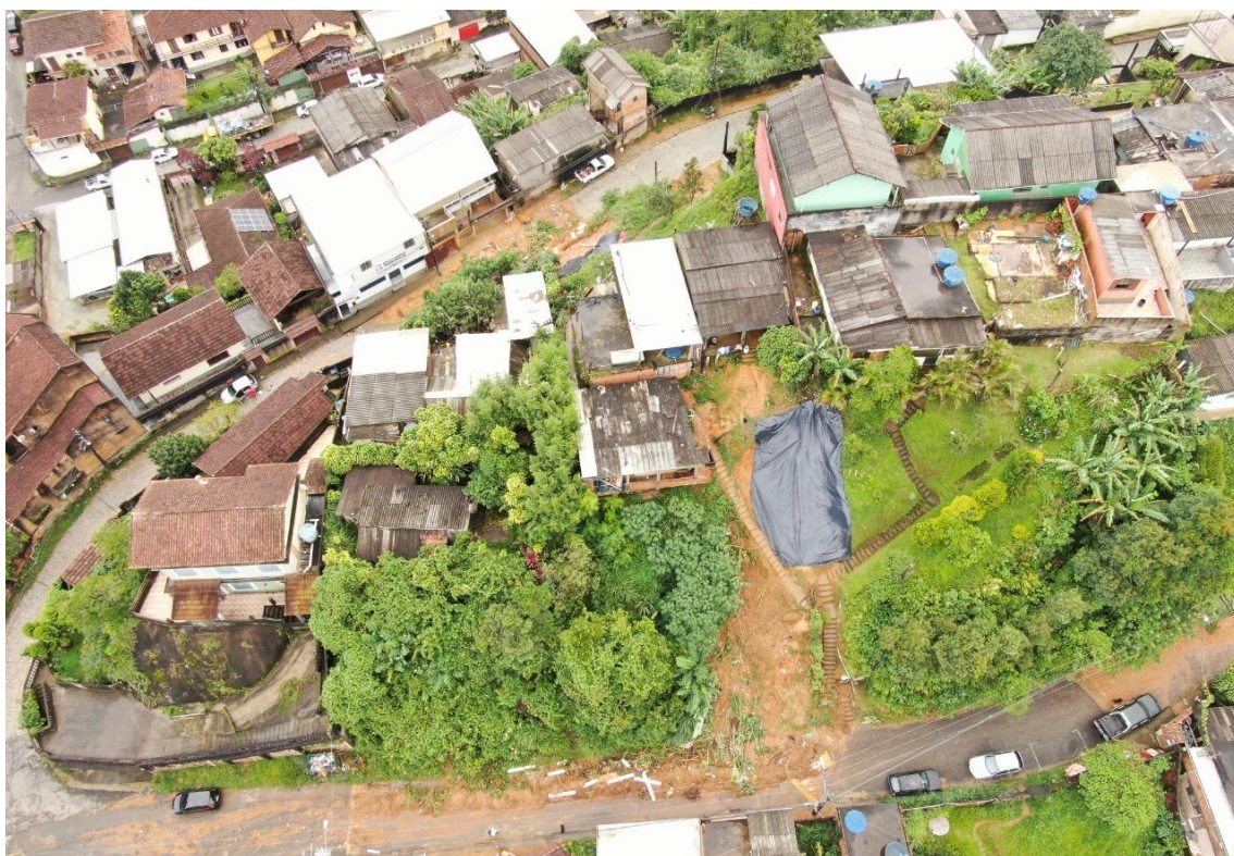
Figura 03. Deslizamento a jusante do imóvel causando obstrução da via.
