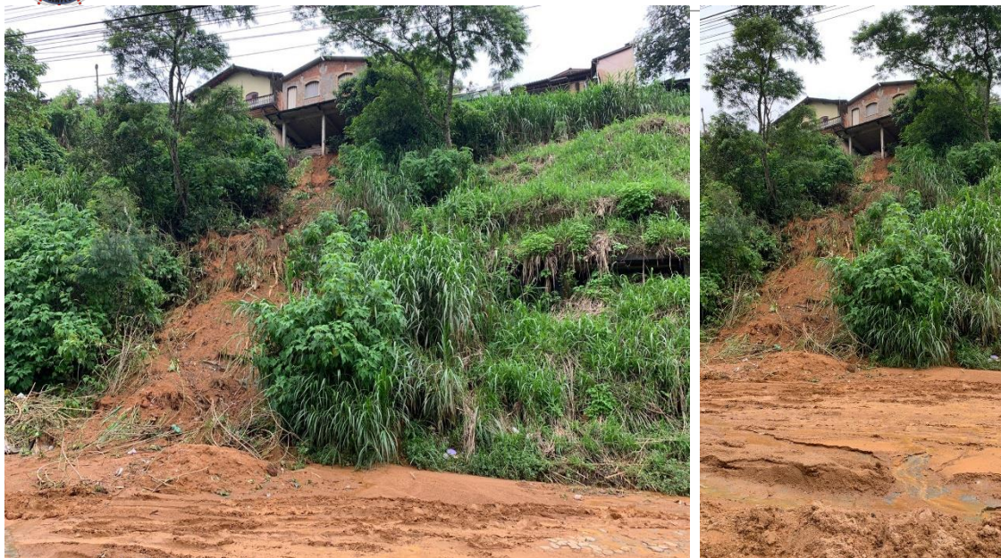
Figura 1 e 2. Imóvel com deslizamento a jusante, localizado na Rua Alagoas
