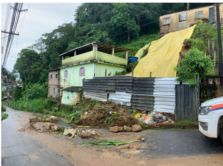
Figuras 01 e 02. Imóvel com deslizamento a jusante comprometendo parte da via.
