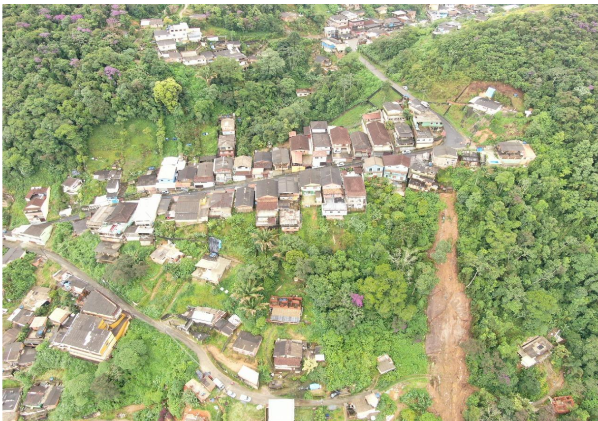
Figura 02. Escorregamento de massa que pegou da Rua Ceará até a Rua Maranhão.
