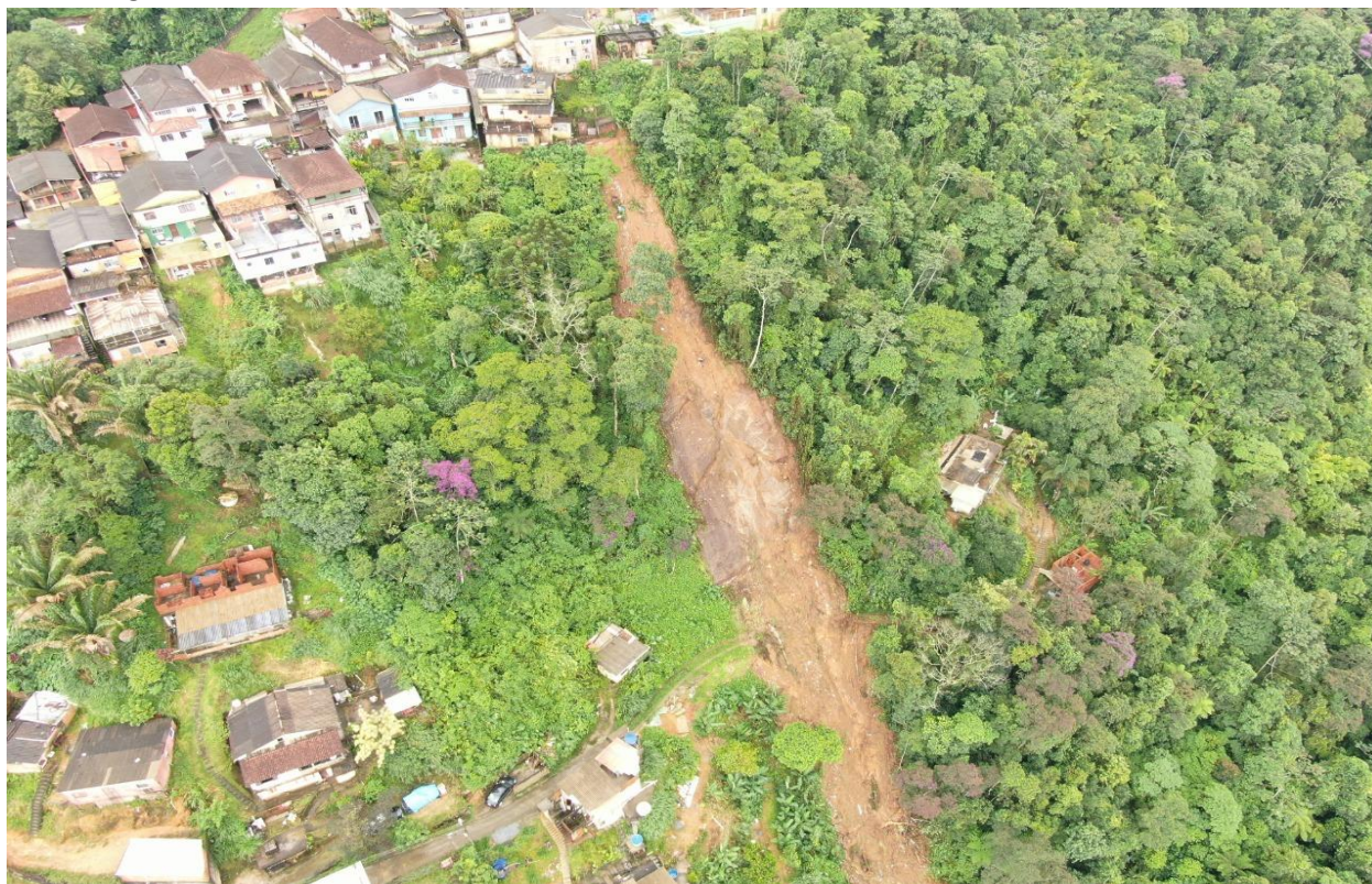
Figura 01. Escorregamento de massa que pegou da Rua Ceará até a Rua Maranhão
