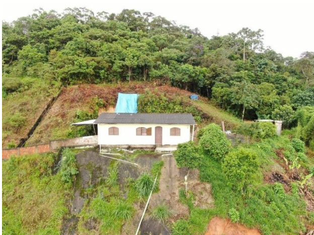
Figuras 01 e 02. Imóvel com deslizamento a jusante e a montante
