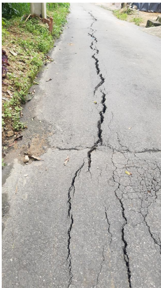
Figuras 3 (a) (b). Fotos da rachadura encontrada na via.
