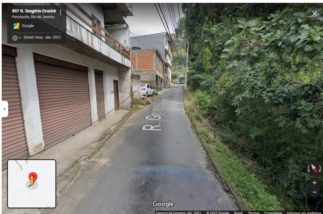
Figura 2. Imagem (Google - Street View) do trecho da rua que agora apresenta rachadura.
