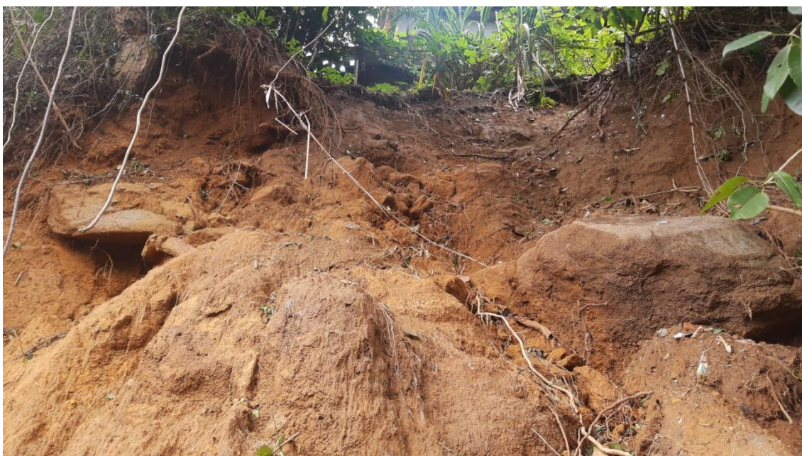
Figura 8. Imagem do talude que deslizou, podendo ser vistos blocos rochosos e uma árvore já com suas raízes expostas.
