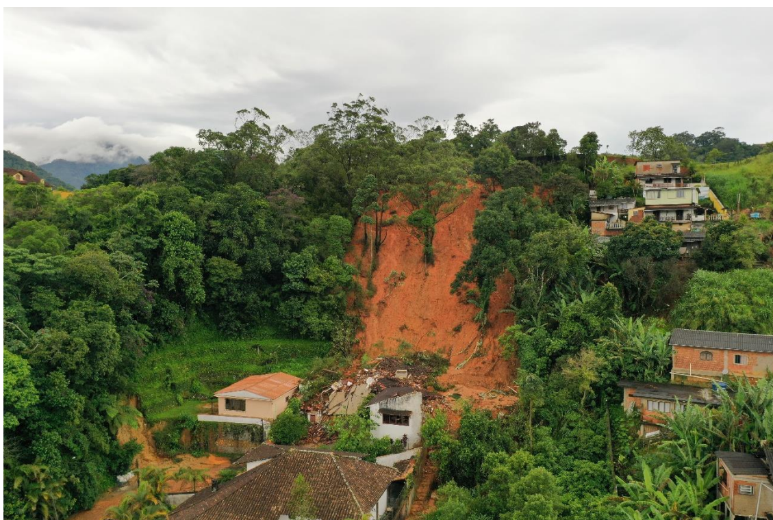
Foto 1 do deslizamento a jusante sobre o imóvel
