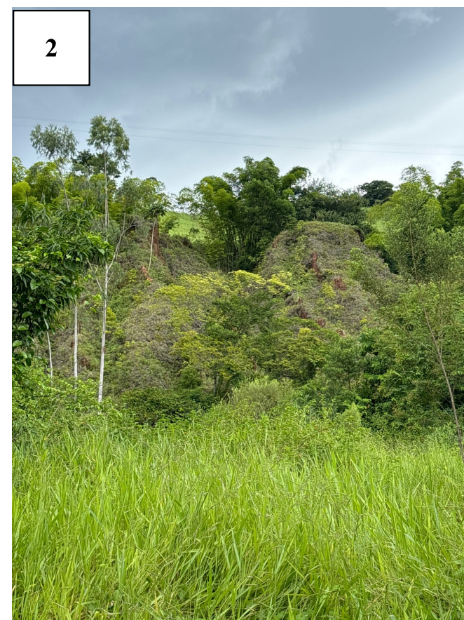
Visada frontal da encosta, com a rodovia RJ-142 a montante
