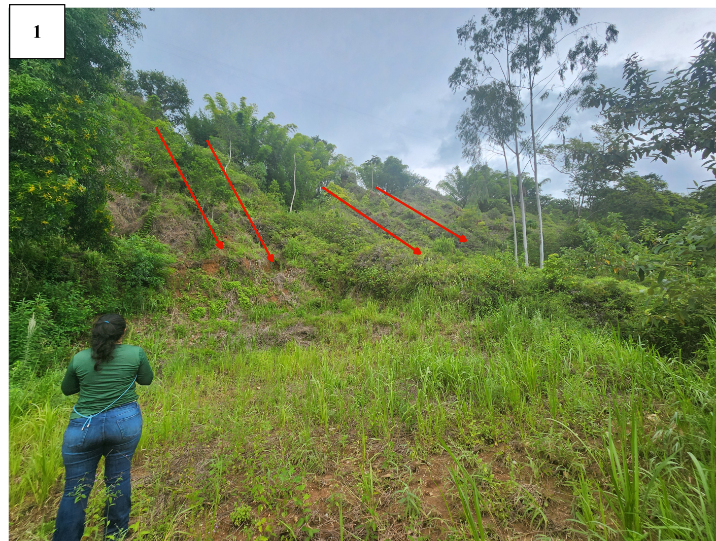
Encosta a montante da Av. dos Pássaros com marcas de erosão (sulcos marcados em vermelho) e com histórico de deslizamentos.
