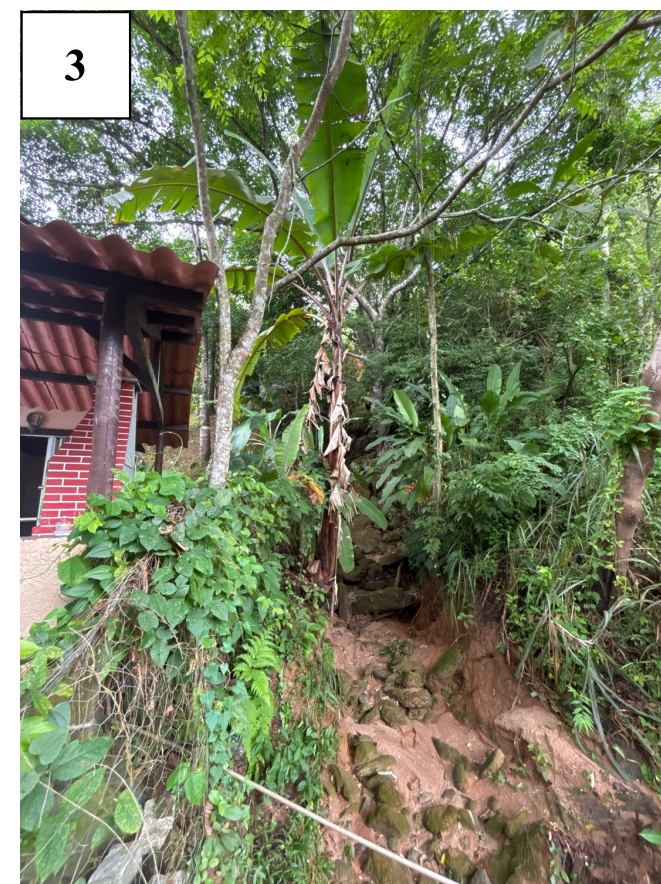
Drenagem aos fundos da casa de N° 12, que recebe grande fluxo descendente durante chuvas intensas acelerando o processo de erosão.
