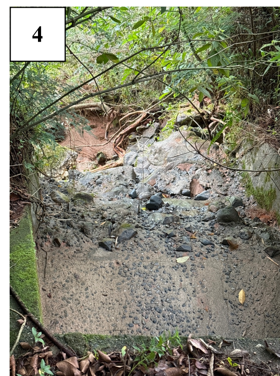
Final da canaleta de drenagem da RJ-142 direcionando o fluxo de águas pluviais para o caminho de drenagem a montante da casa de N° 12 da Av. dos Passaros
