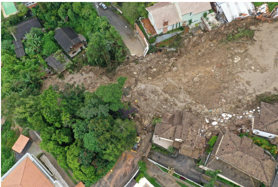
Figura 2. Destaque para o fluxo de detritos que atingiu as residências e obstruiu a via pública.
