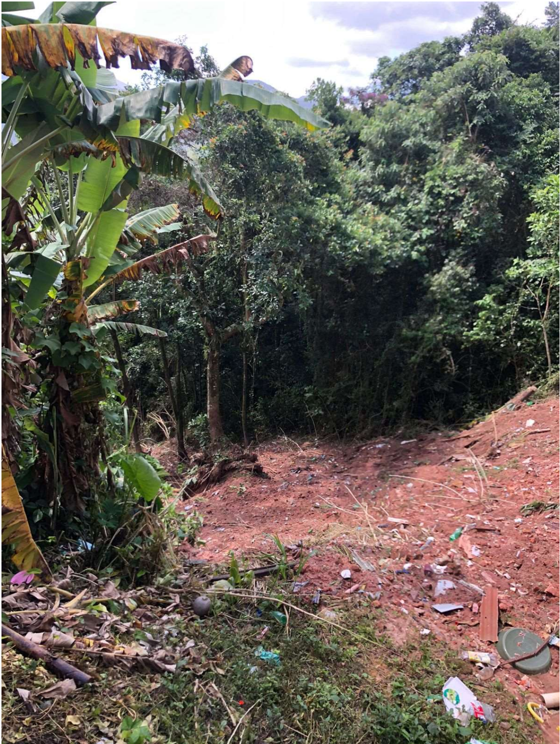
Figura 5: Deslizamento na Rua Nova
