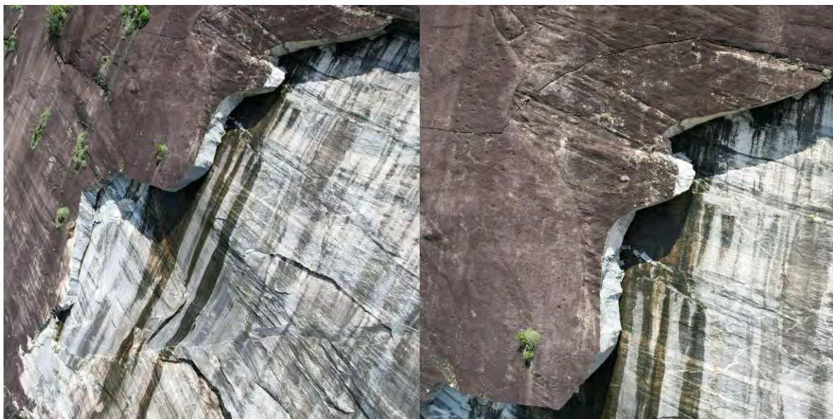
Figuras 10 e 11: Fratura com percolação de água entre o plano de fratura e a encosta. Destaque para a vista frontal da fratura.
