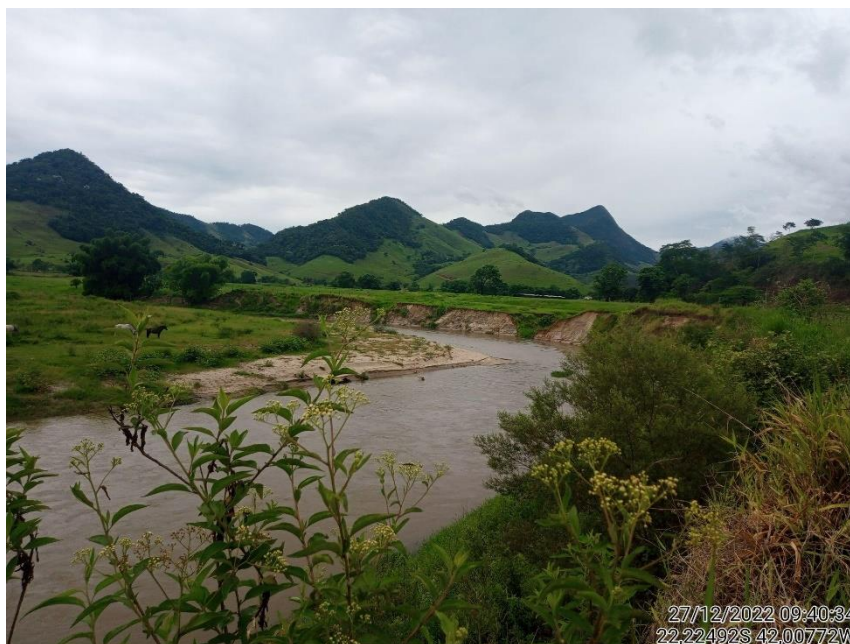
Figura 2: Processo erosivo na margem do rio em progresso.
