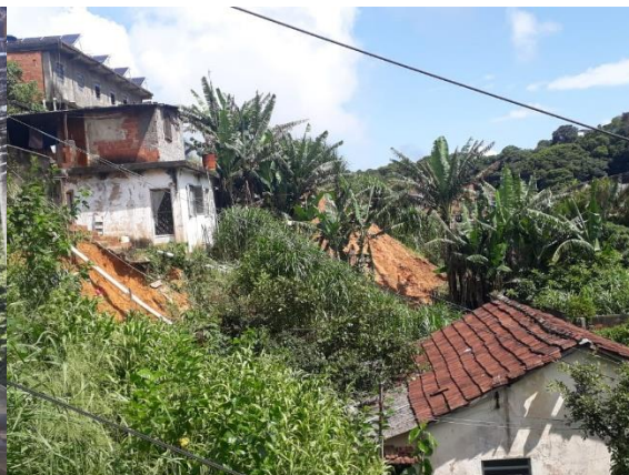
Nas proximidades do nº 495, deslizamento ocorridos.
