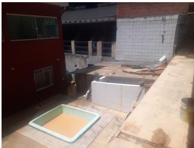
Casa ao fundo da 140L, que foi inundada.
