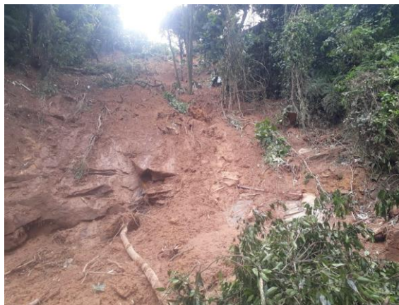
Grande deslizamento ocorrido.
