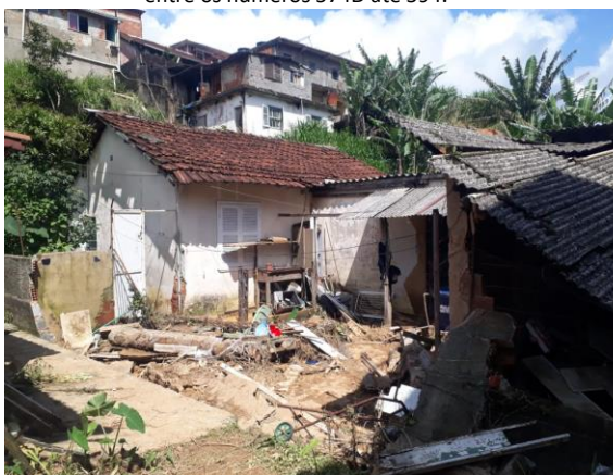
Casas com danos parciais nas proximidades do nº 495.
