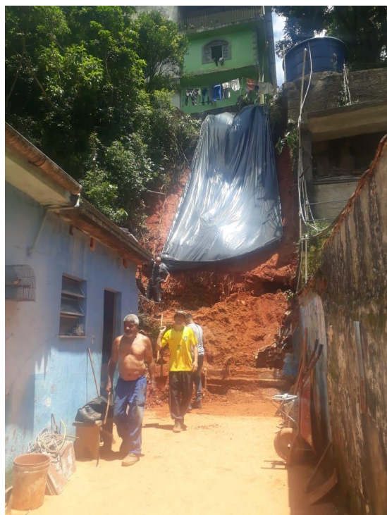
Casa nº 144, com talude de fundo que atingiu a propriedade.
