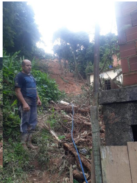
O deslizamento atingiu uma das casas até o momento dessa vistoria.
