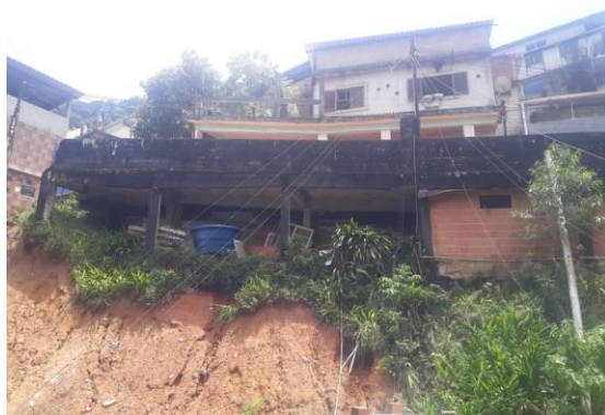
Final da Rua Manuel Antônio da Costa, com os pilares no topo do talude onde houve deslizamento.
