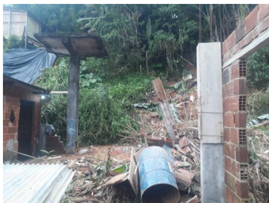
Casas atingidas pelo deslizamento.
