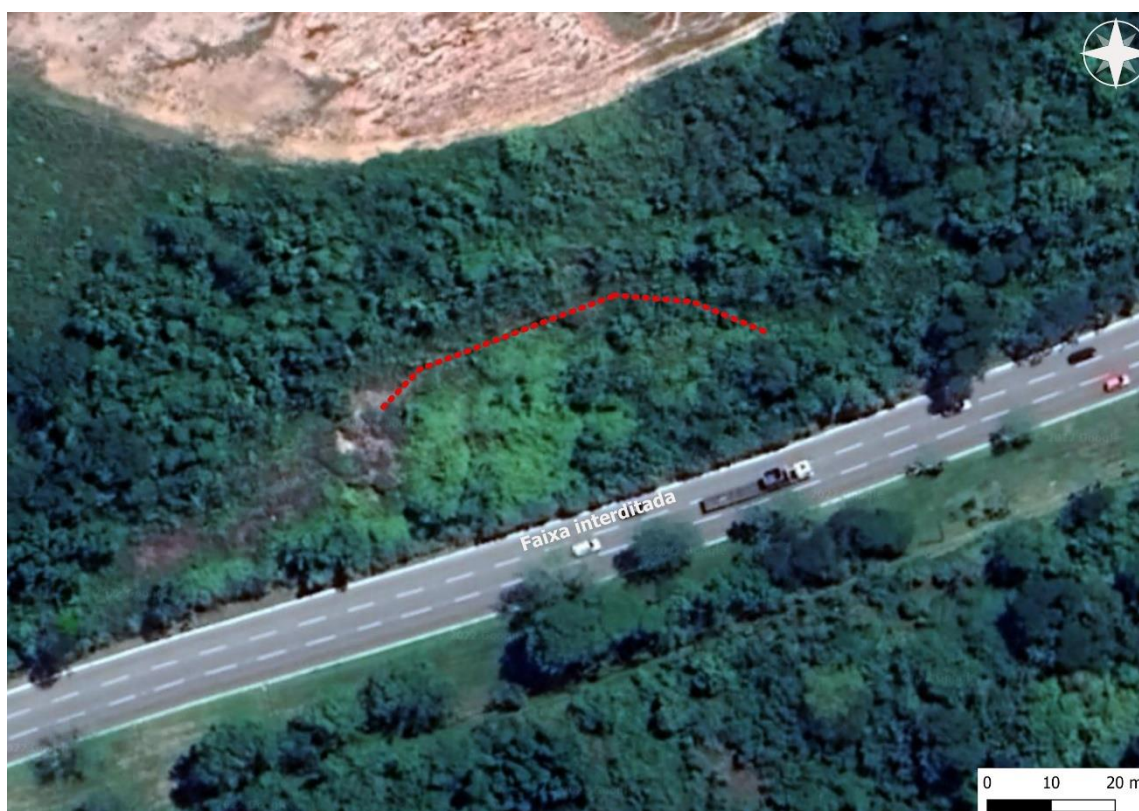
Figura 2: Localização do deslizamento na Rodovia Amaral Peixoto.
