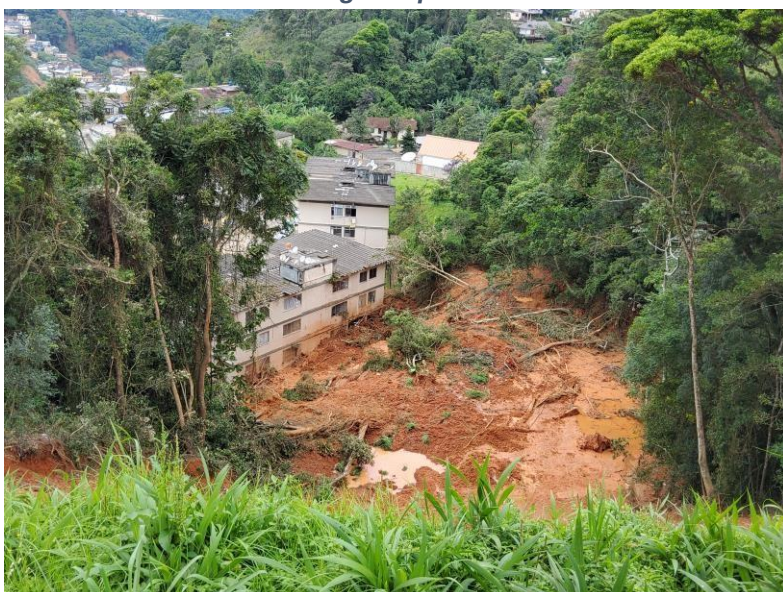
Foto 5 - Deslizamento atingido e comprometendo a estrutura do bloco 18;
