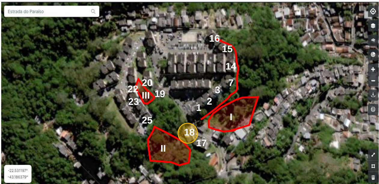
Imagem Google Earth 3 - Deslizamentos corridos no Condomínio Chácara Flora;
