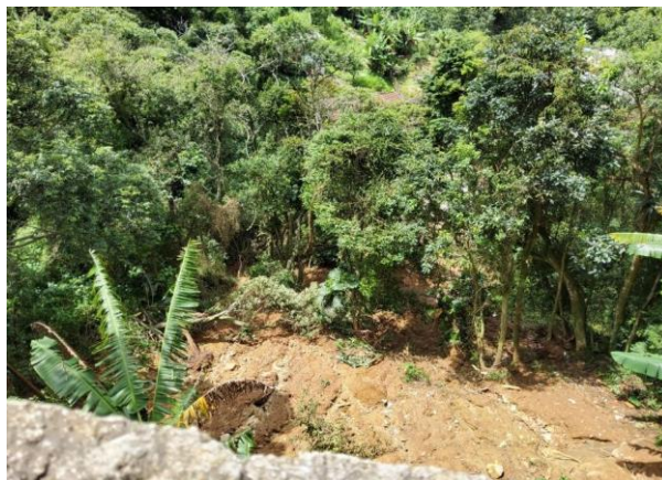
Foto 2 - Amplitude do deslizamento;
