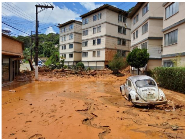
Foto 4 - Blocos 18 e 17 atingidos por deslizamento a montante;
