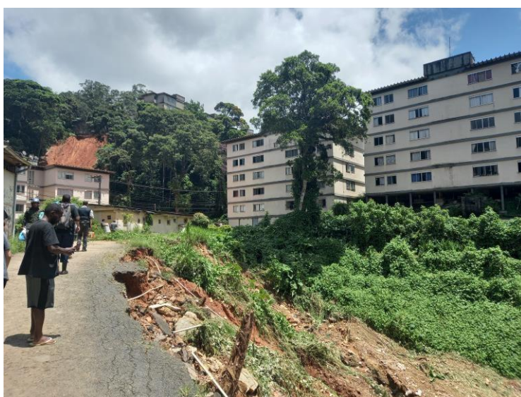
Foto 6 - Deslizamento a jusante dos blocos 1, 2 e 3;
