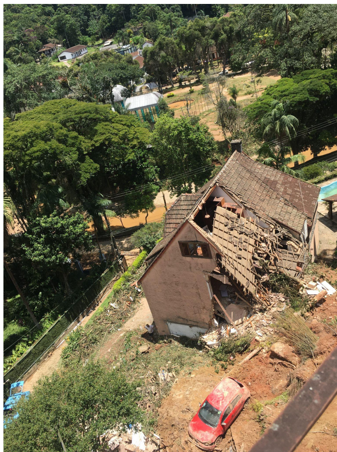
Vista superior da destruição do imóvel da Rua Padre Siqueira
