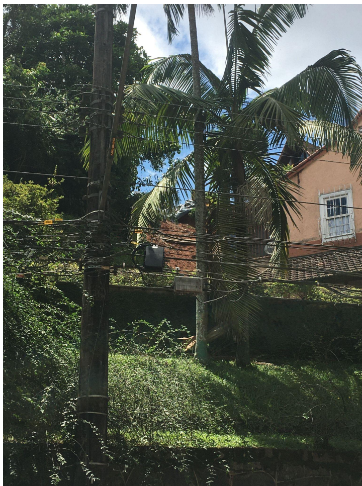
Deslizamento visto da Rua Padre Siqueira
