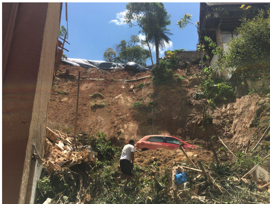
Dois carros que estavam na Rua Domingos de Andrade Bastos foram derrubados pelo deslizamento
