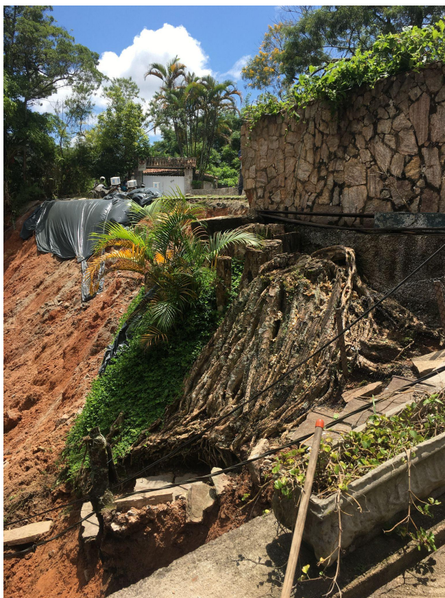
Parte superior do local onde se iniciou o deslizamento
