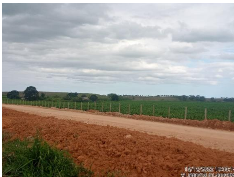
Figura 4 – Estrada de terra aberta como medida paliativa.
