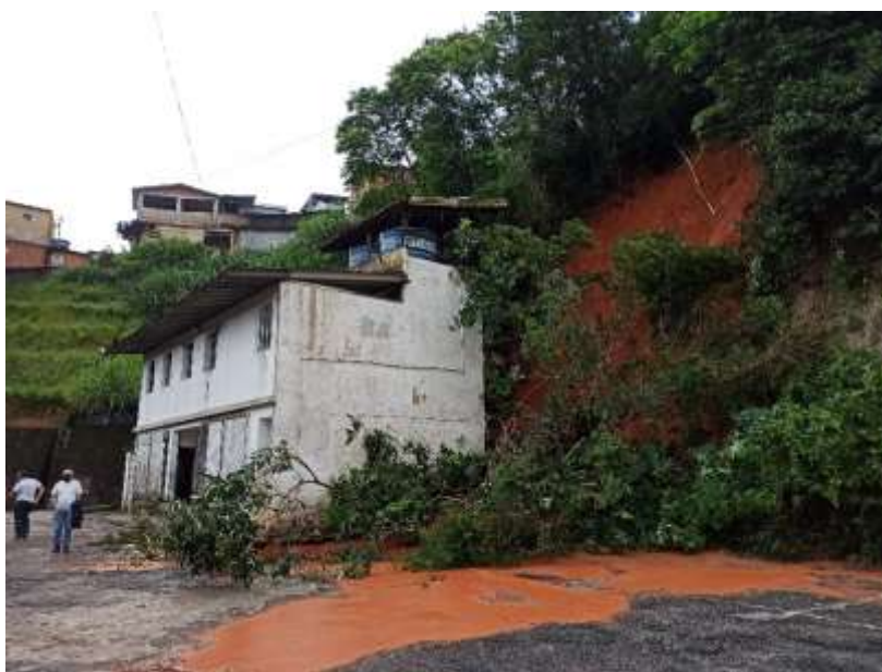
Figura 1. Prédio e pátio interditados, localizado nos fundos do hospital.
