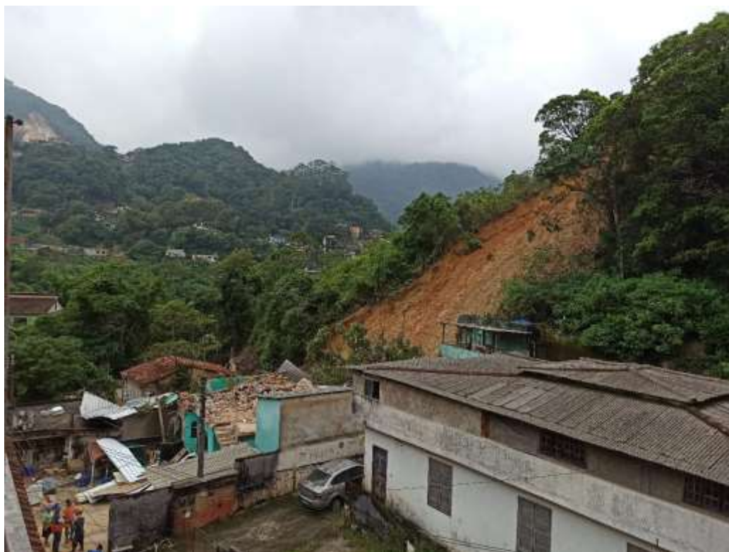
Figura 7. Visada lateral das casas destruídas pelo deslizamento na rua Alfredo Batista.
