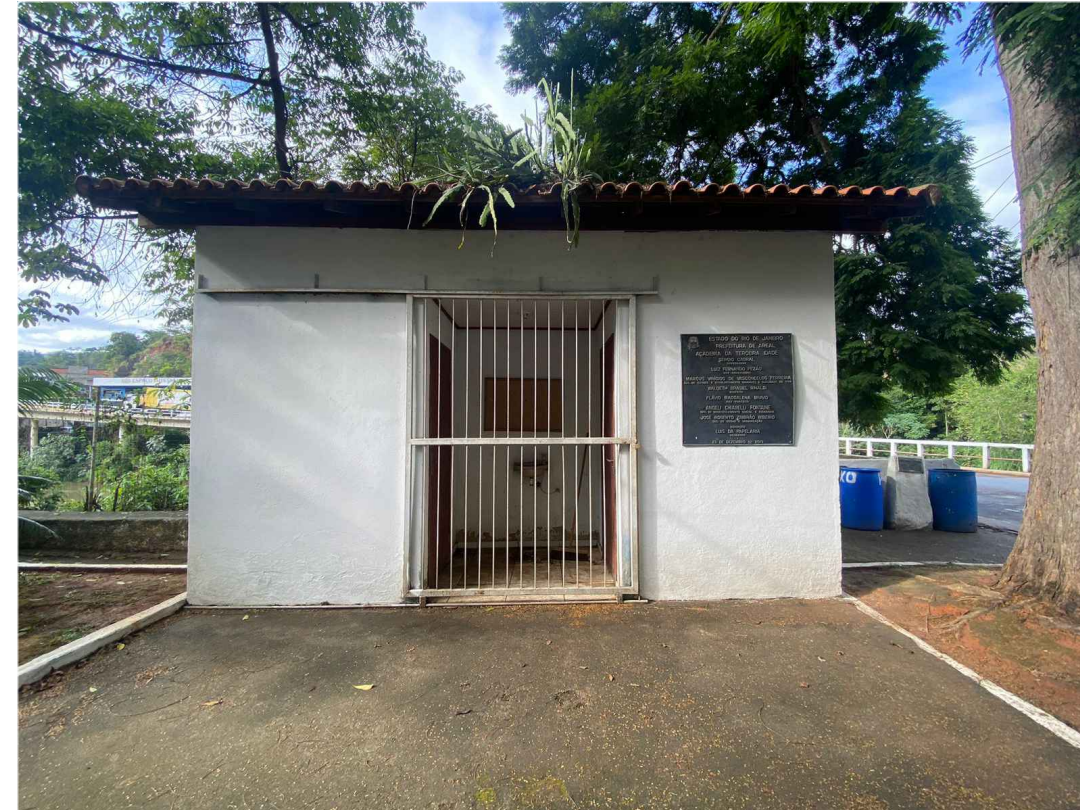
02 IMAGEM FACHADA SANITÁRIOS
