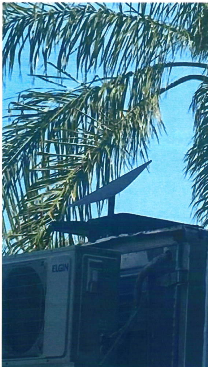
Sistema de comunicação Starlink instalado sobre o caminhão. (9:45)
