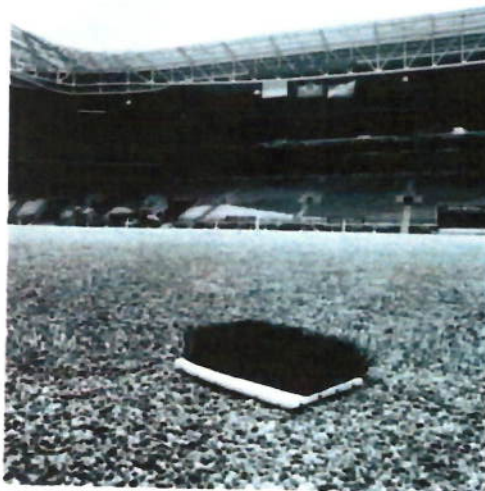
FOTO 78 - DISTRIBUIÇÃO DAS PLACAS DE GRAMA SINTÉTICA
