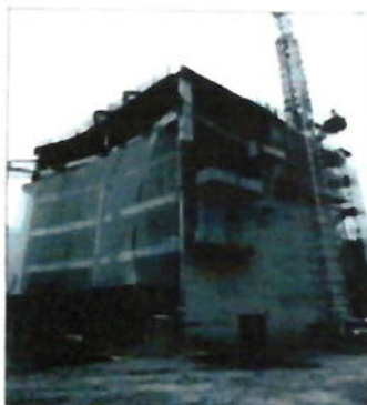
FOTO 20 - Estruturas de Concreto - Casas das Escadas
