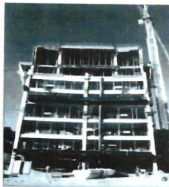
FOTO 21 - Estruturas de Concreto - Casas das Escadas
