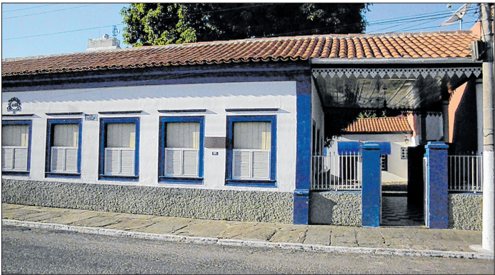
Edifício é um exemplar típico da arquitetura colonial
