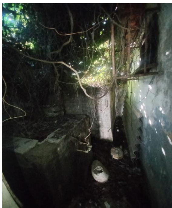
29 - VISTA DOS FUNDO
