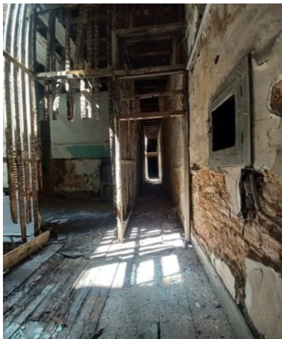
20 - VISTA DA ÁREA
