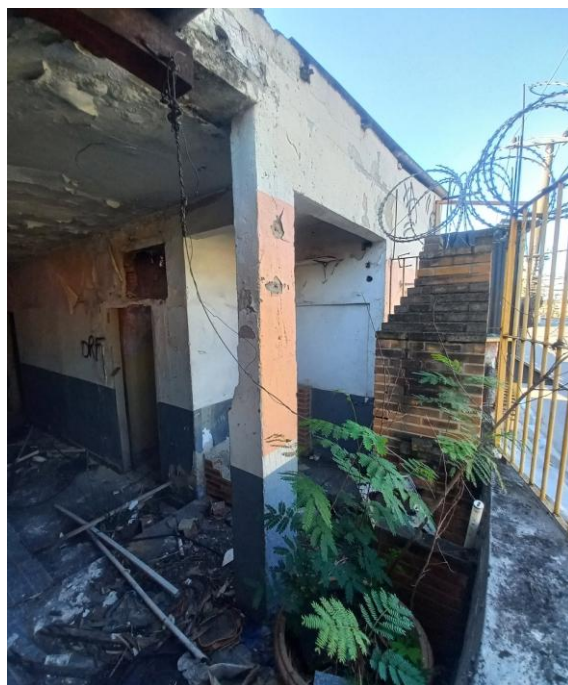
19 - VISTA NA ESTRADA DA EDIFICAÇÃO
