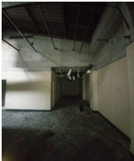
9 - ÁREA DE CIRCULAÇÃO(ANTIGO SALA DE ATENDIMENTO)
