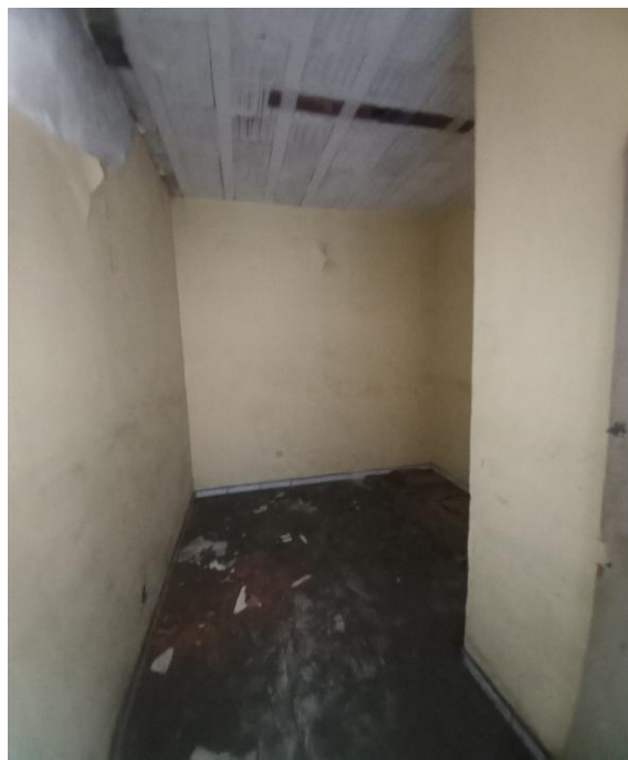
21 - VISTA DA SALA
