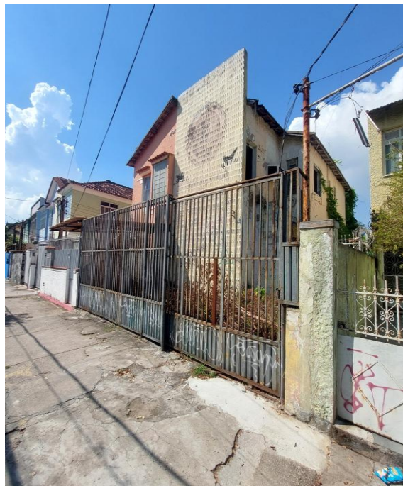
5 - VISTA LATERAL DO IMÓVEL
