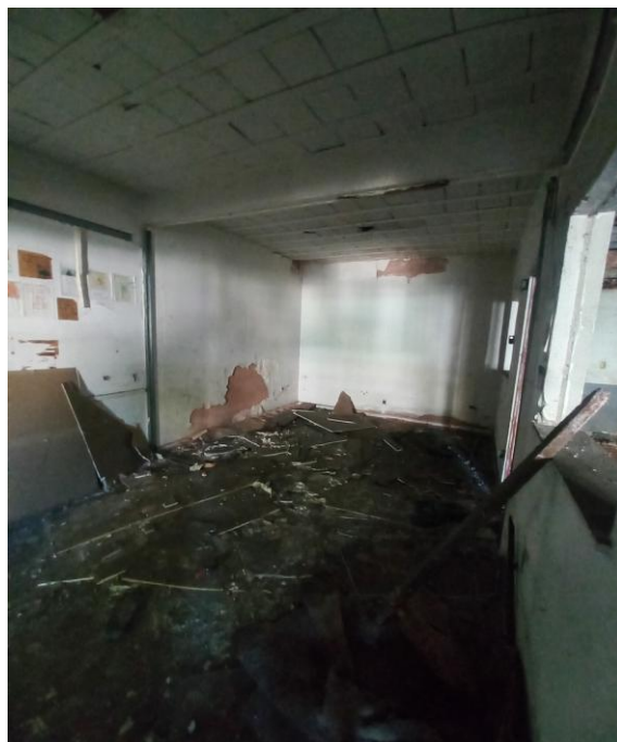
23 - VISTA DA SALA 2
