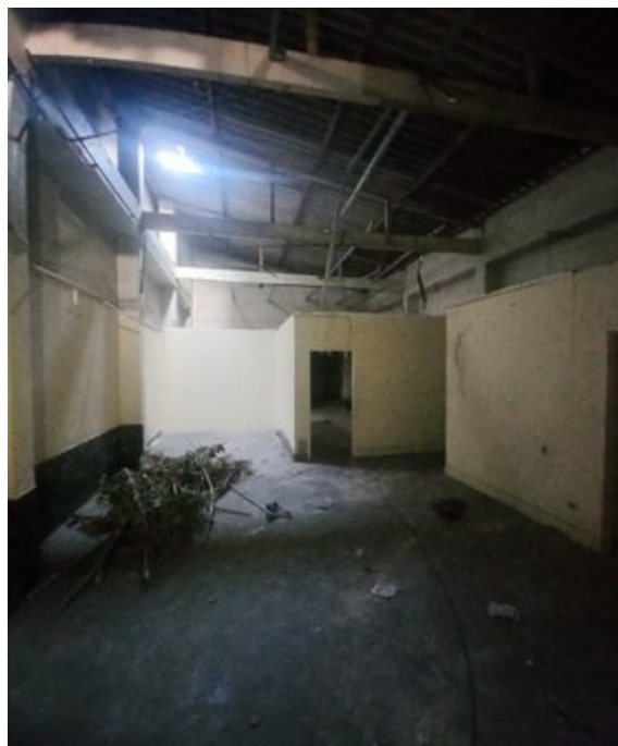
17 - VISTA DA ÁREA DE CIRCULAÇÃO(DESATIVADA)
