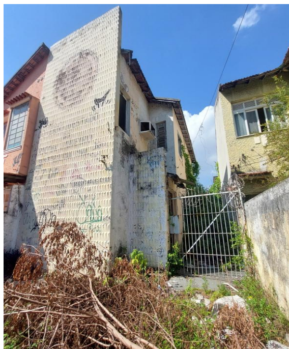
3 - VISTA DO IMÓVEL 2
