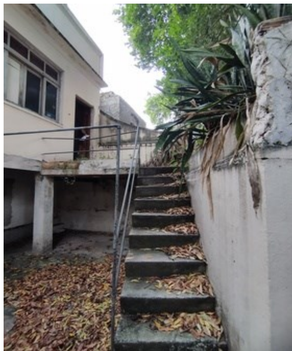
23 - ESCADA DE ACESSO
