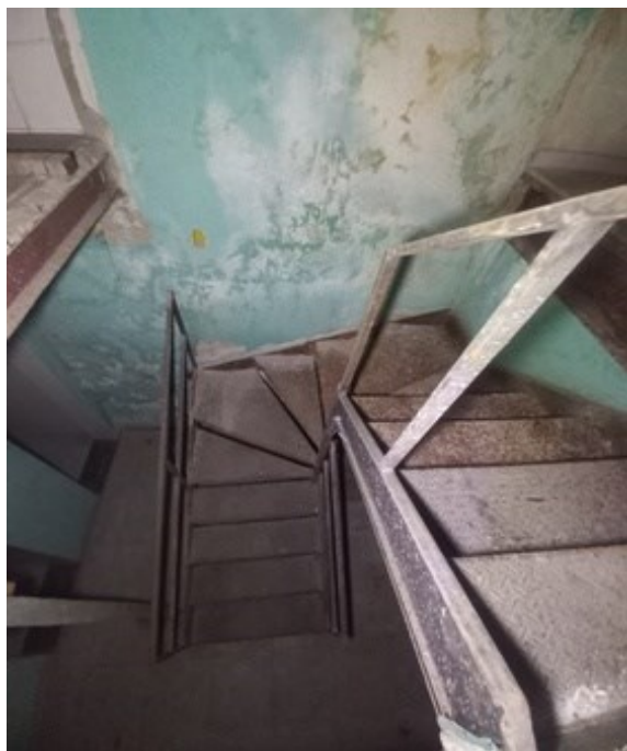
16 - ESCADA DE ACESSO FUNDOS
