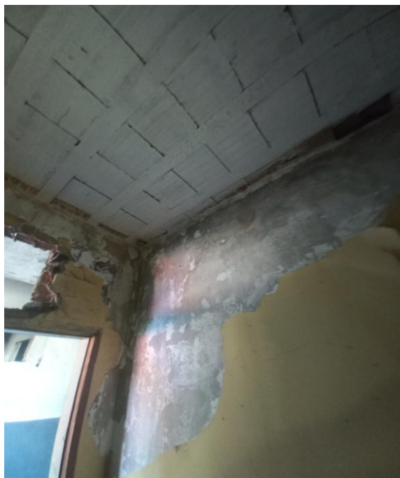
22 - DETALHE DO TETO DA SALA
