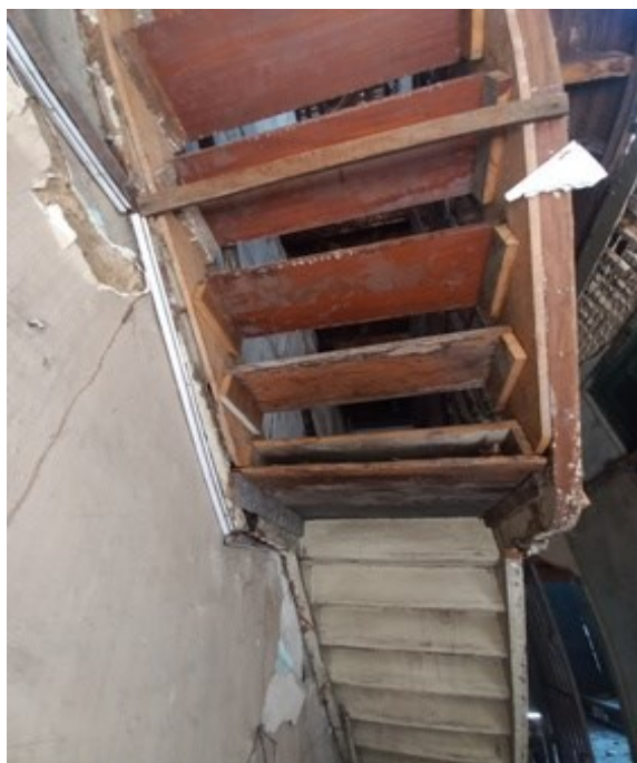
18 - ESCADA DE ACESSO
