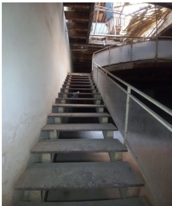
12 - ESCADA DE ACESSO
