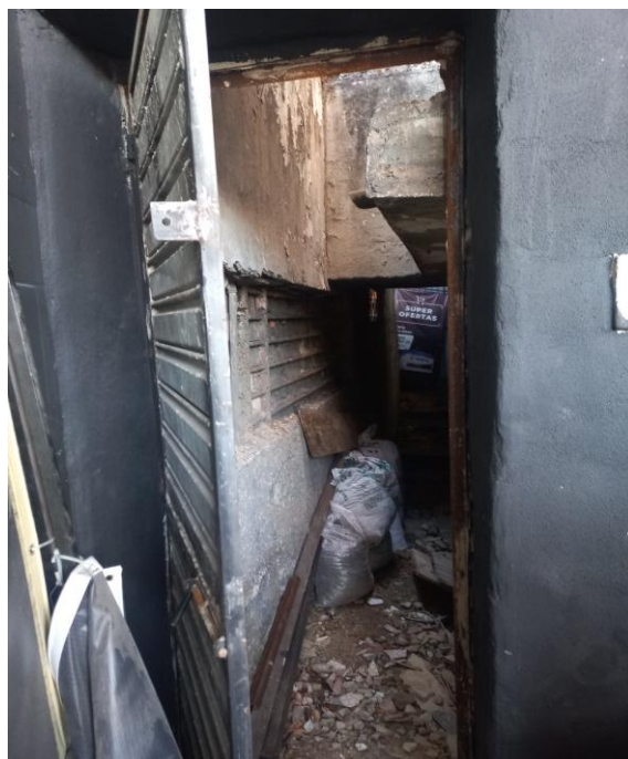
3 - PORTA DE ACESSO LOJA DE BATERIAS
