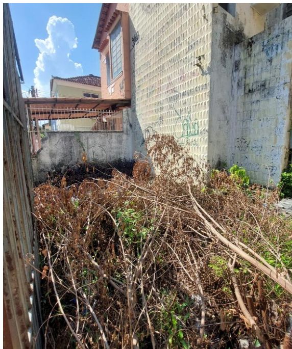
4 - VISTA DO IMÓVEL 3
