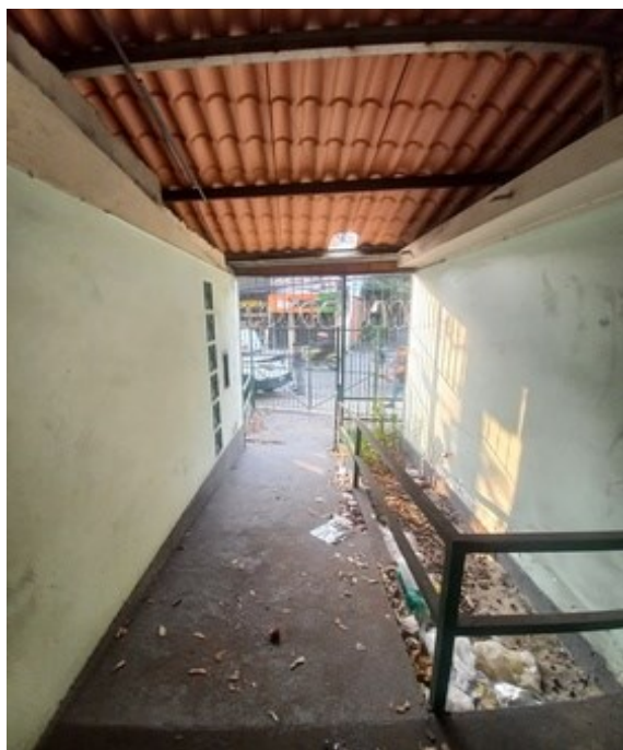
2 - VARANDA( ACESSO AO IMÓVEL)
