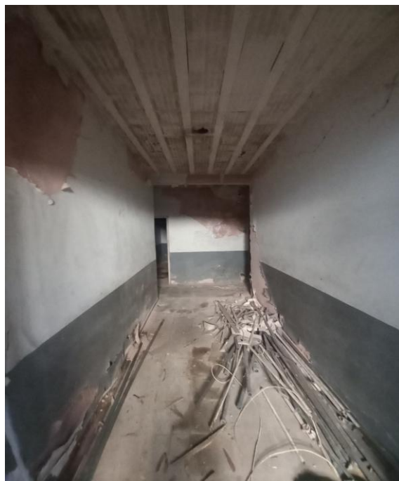
13 - ÁREA DE CIRCULAÇÃO INTERNA
