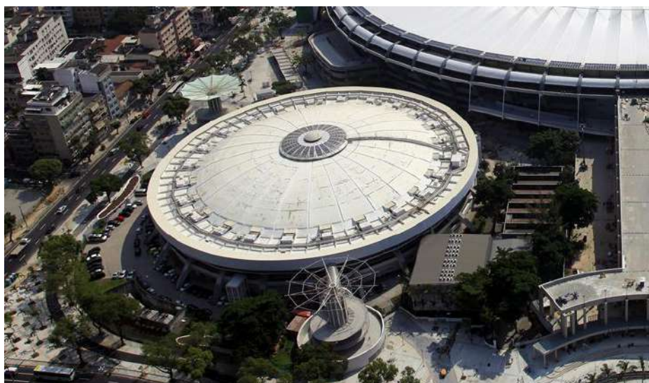
Figura 34: Imagem aérea da cobertura do Ginásio Maracanzinho
