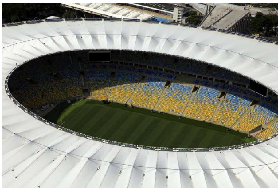
Figura 18: Detalhe da Cobertura do Estádio Maracanã
