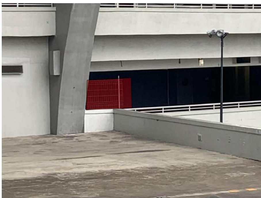
Figura 23: Bloqueio fixo na rampa para evitar que espectadores pulem de um setor ao outro
