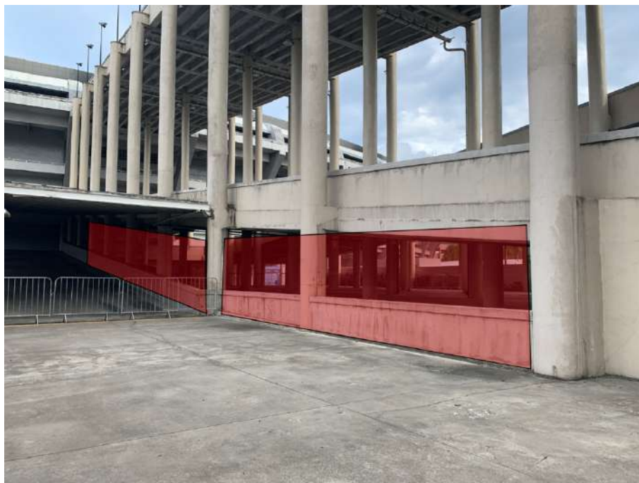
Figura 20: Posição sugerida de cercamento do espaço de divisão de torcida, evitando que haja acesso indevido de torcedores de um espaço para o outro
