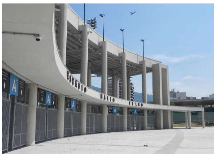
Figura 33: Acesso Oeste (UERJ)
