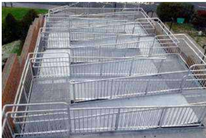
Figura 30: Imagem real grades em zigue e zague para pedestres
