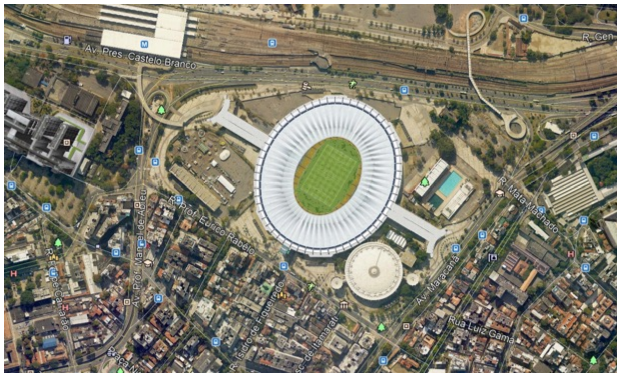
Figura 5: Visão geral do entorno do Maracanã
