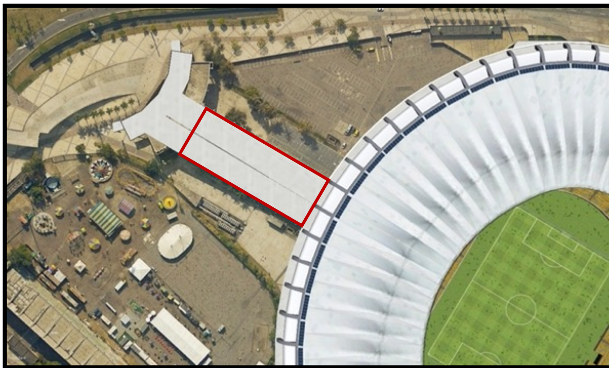
Figura 38: Espaço localizado no Setor Oeste sob a Rampa A. Em dia de jogos, é o principal ponto de acesso aos Setores VIP e VVIP.
